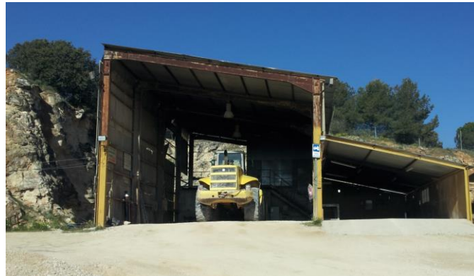
Imagen 13. Detalle de la nave taller.
