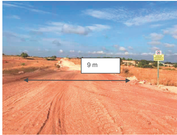
Imágenes 21. Camino hacia frente 4. Vista hacia el este (X=477.455 Y=4.460.013)
