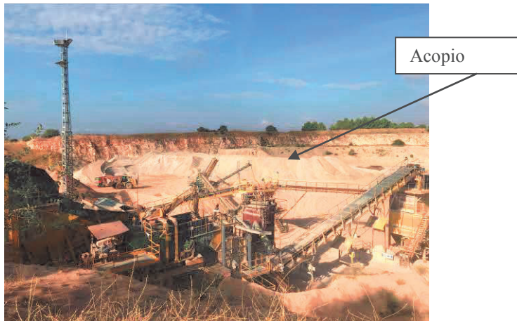
Imagen 4. Zona de Hoya de la Minga. Acopio de material. Vista hacia el oeste (X=477.455 Y=4.460.013)
