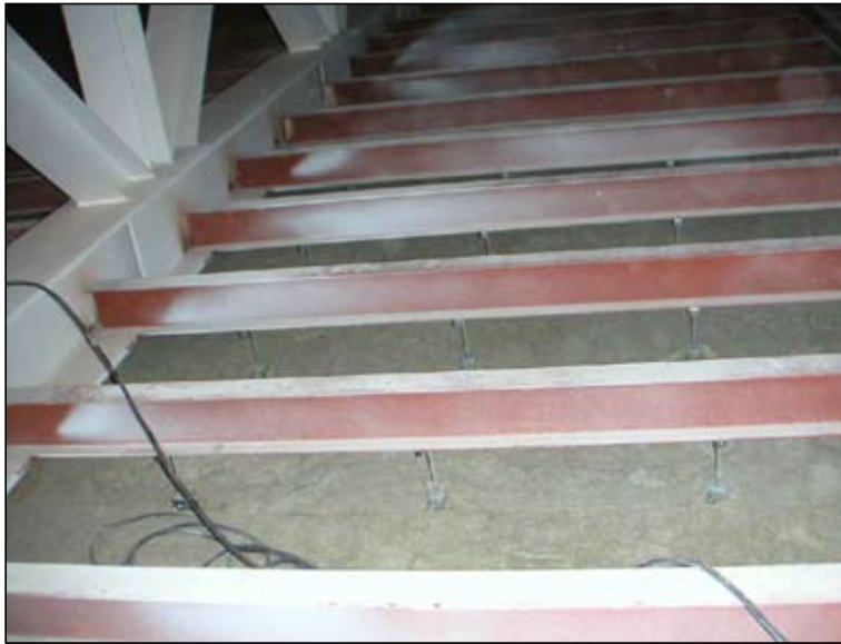
FOTOGRAFÍA DESDE LA PARTE SUPERIOR DEL TECHO SE APRECIA LA ESTRUCTURA AUXILIAR, ELEMENTOS DE FIJACIÓN DEL TECHO Y CAPA DE AISLAMIENTO ACÚSTICO
