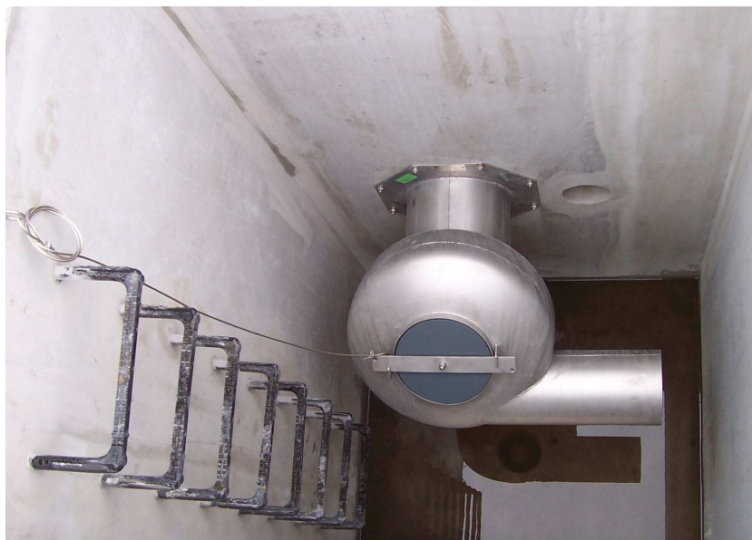
VALVULA REGULADORA VORTEX CÓNICA, MODELO CLEAN WATER-UFT FLUIDCON-n DE 45 GRADOS DE INCLINACIÓN, PARA UN CAUDAL MÁXIMO DE l/s Y UNA ALTURA DE METROS (PLANTA DE ARCELOR EN AVILES, ASTURIAS)
