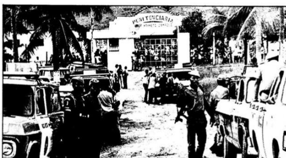
Na Penitenciária Barreto Campelo, os muros foram substituídos por cercas eletrificadas, que dificultam as fugas
