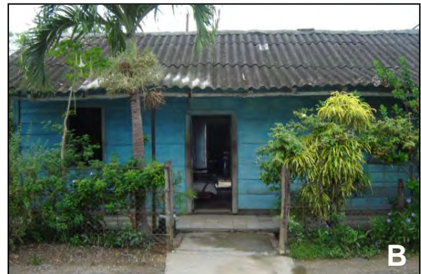
Figura 4. Ejemplos de viviendas de tipología IV. A: Con cubierta de teja de barro. B: Con cubierta de planchas de asbesto cemento.
