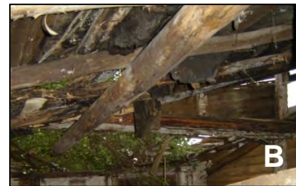
Figura 16. Techos totales. A: Ejemplo de pérdida total de elementos de cubierta. B: Ejemplo de roturas de gran magnitud que provocan un estado de inminente derrumbe de toda la cubierta.
