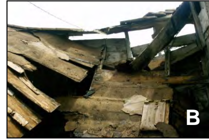
Figura 14. Derrumbes Totales. A: Ejemplo de estado de inminente derrumbe de los elementos componentes de la vivienda. B: Ejemplo de derrumbe total de cubierta que afectó los elementos restantes que se encontraban en mal estado (muros).
