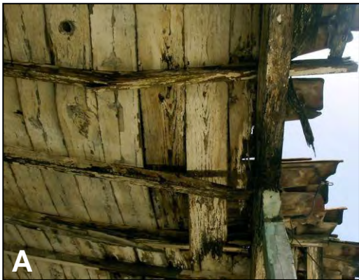
Figura 12. A, B: Rotura de elementos de cubierta.
