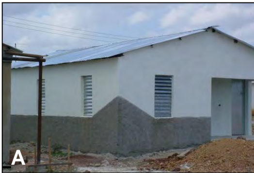
Figura 3. Ejemplos de viviendas de tipología III. A: Con cubierta de planchas metálicas. B: Con cubierta de canalones de asbesto cemento.
