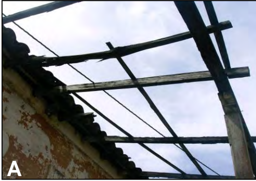
Figura 11. A, B: Pérdida de elementos de cubierta.
