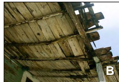
Figura 17. Techos parciales. A: Ejemplo de pérdida de una porción de los elementos de cubierta, en este caso del portal de la vivienda. B: Ejemplo de roturas en elementos de la cubierta que ponen en estado de inminente derrumbe una porción de esta estructura (Portal).
