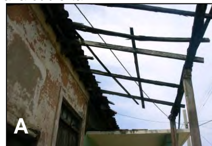
Figura 17. Techos parciales. A: Ejemplo de pérdida de una porción de los elementos de cubierta, en este caso del portal de la vivienda. B: Ejemplo de roturas en elementos de la cubierta que ponen en estado de inminente derrumbe una porción de esta estructura (Portal).
