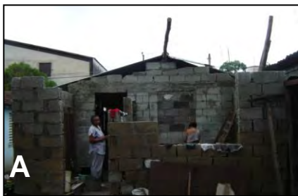
Figura 15. Derrumbe parcial. A, B: Ejemplo de derrumbe de una porción de la cubierta y los muros de una vivienda.
