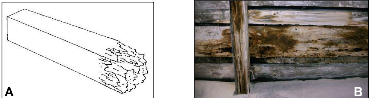
Figura 9. Pudriciones. A: Esquema de pudrición. B: Ejemplo de pudrición en viguetas y entablado.
