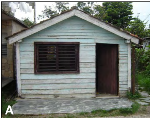
Figura 4. Ejemplos de viviendas de tipología IV. A: Con cubierta de teja de barro. B: Con cubierta de planchas de asbesto cemento.
