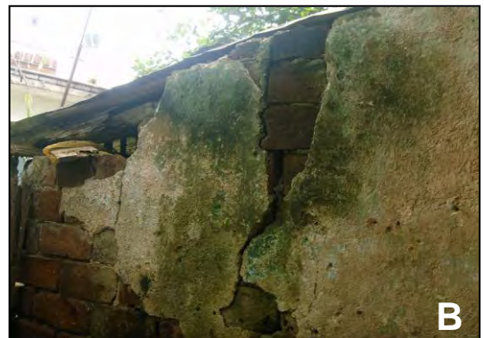
Figura 13. Agravamiento de patologías. A: Aumento de la magnitud de un pandeo. B: Aumento de las dimensiones de grietas.
