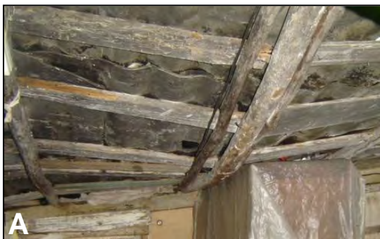
Figura 7. A, B: Flechas excesivas en viguetas.
