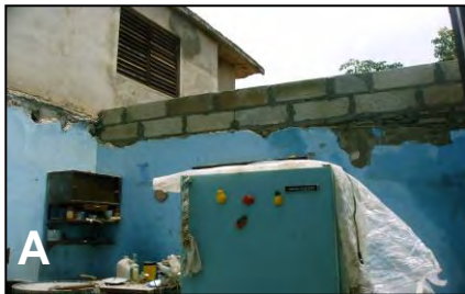
Figura 16. Techos totales. A: Ejemplo de pérdida total de elementos de cubierta. B: Ejemplo de roturas de gran magnitud que provocan un estado de inminente derrumbe de toda la cubierta.
