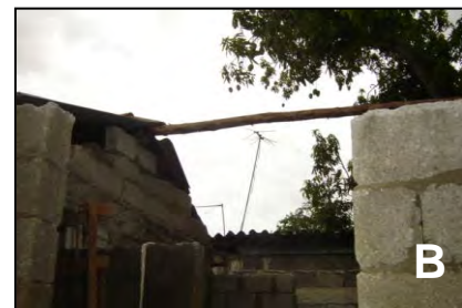
Figura 15. Derrumbe parcial. A, B: Ejemplo de derrumbe de una porción de la cubierta y los muros de una vivienda.
