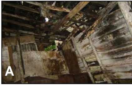
Figura 14. Derrumbes Totales. A: Ejemplo de estado de inminente derrumbe de los elementos componentes de la vivienda. B: Ejemplo de derrumbe total de cubierta que afectó los elementos restantes que se encontraban en mal estado (muros).
