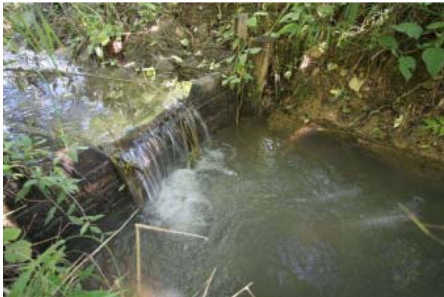
Photo 3 : Seuil sur le ruisseau des Sagnes, en amont de la passerelle
