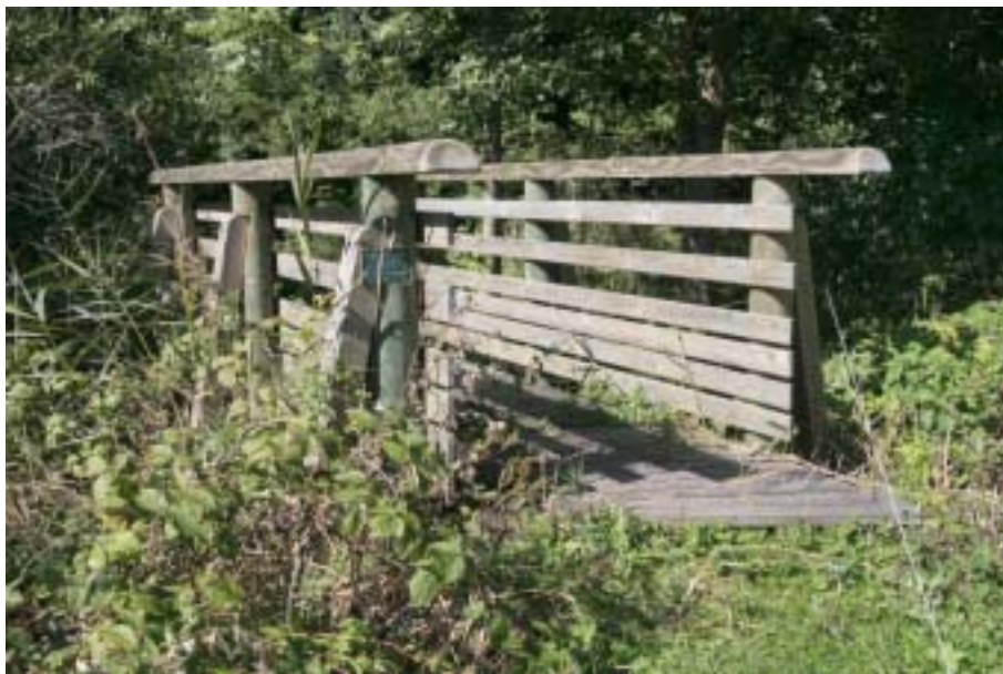
Photo 4 : Passerelle de bois, franchissement du ruisseau des Sagnes.
