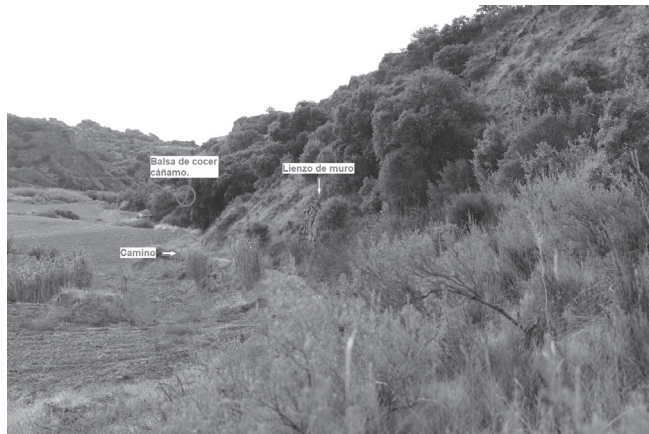
FIGURA 7: Camino de Tamarite de Litera a Albelda y situación del muro y la balsa
