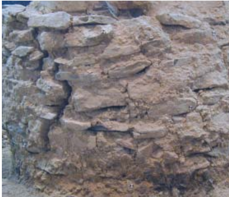
Imagen de una de las cimentaciones de los pilares, en la que puede apreciarse la degradación de los materiales de la fábrica.
