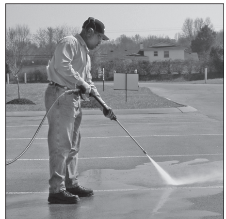
Figure 19 - Angle optimal de nettoyage de la surface
