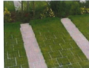
Solution mixte dalles alvéolaire/ pavés Source : Sol-aire
