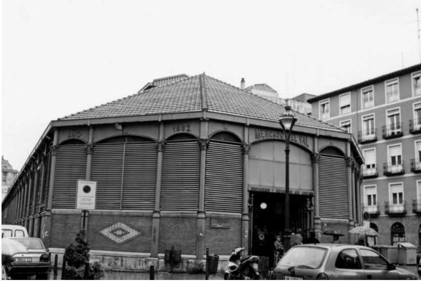
Vista exterior del mercado de El Val, Valladolid, 1878-1882. Arquitecto: Joaquín Ruiz Sierra
