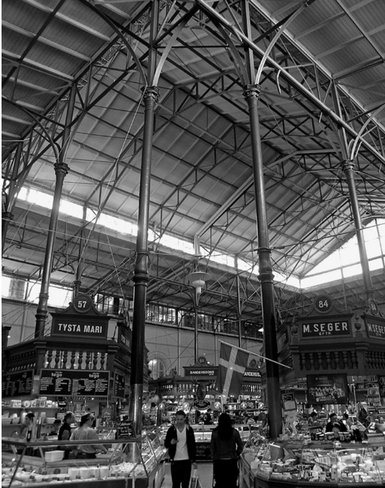
Vista interior del mercado Östermalm, Estocolmo, 1885-1889. Arquitectos: Isak Gustaf Clason y Kasper Salin
