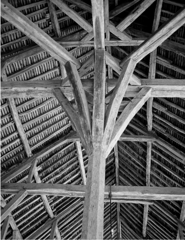
Mercado medieval, Merville. Detalle de la armadura
