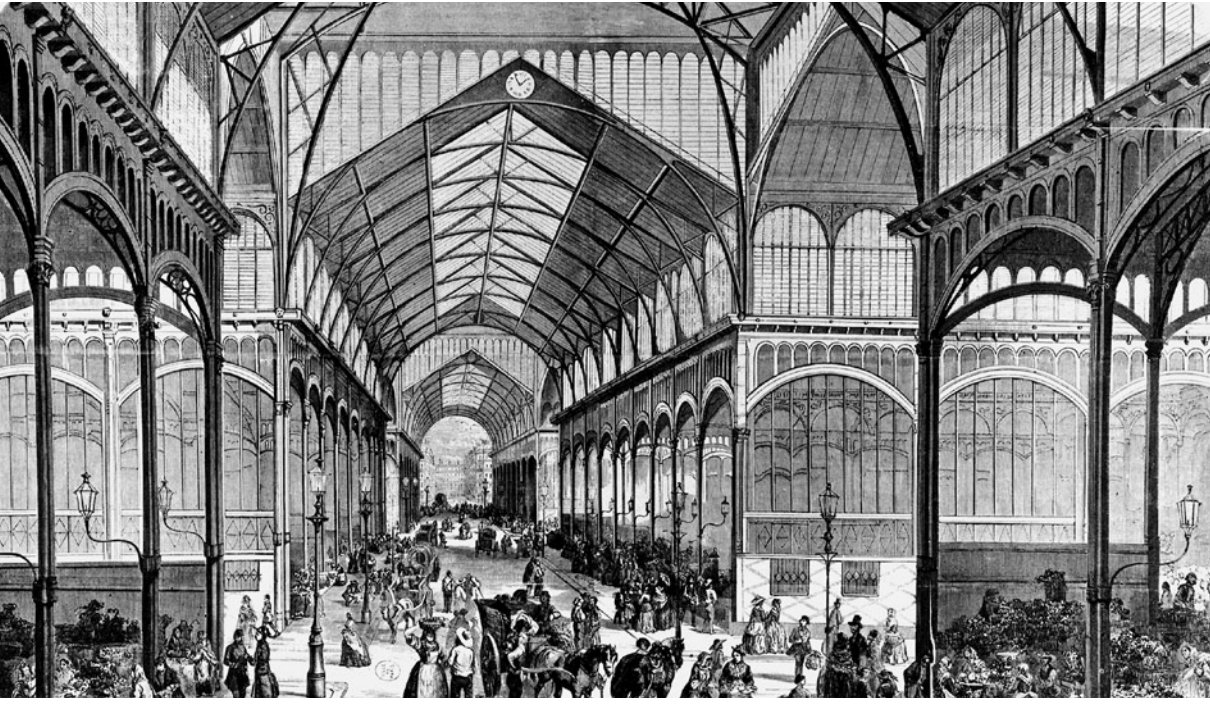
Vista interior de Les Halles y del sistema de carga y descarga de los pabellones por las naves cubiertas
