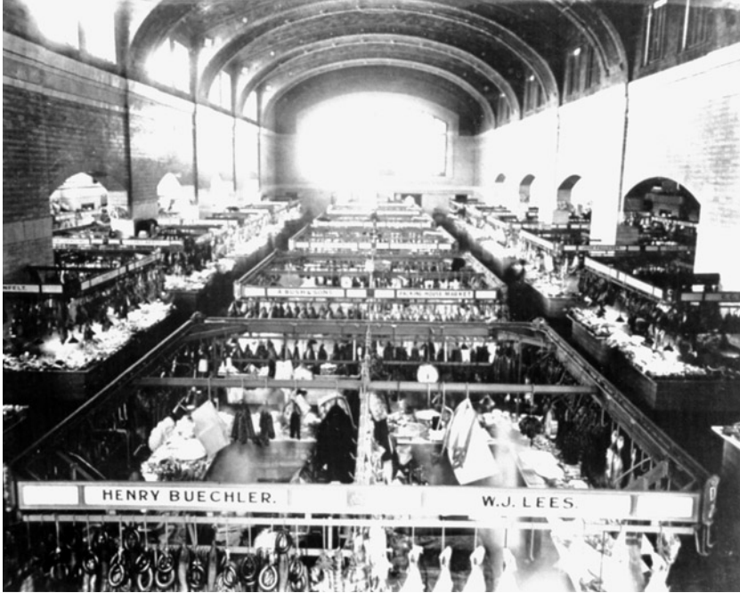
Vista interior del mercado de Cleveland, 1912. Se puede apreciar la gran bóveda realizada por la Guastavino Company
