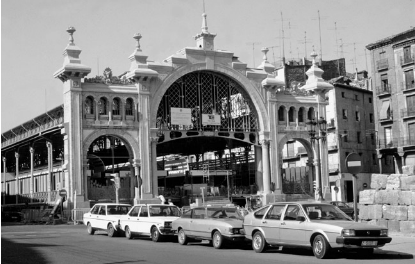
Vista general del mercado de Lanuza, Zaragoza, 1898-1903. Arquitecto: Félix Navarro
