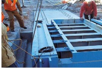
**Construcción avanzada modular** – Un módulo provee pesaje en rieles de hasta de 3.8 m (12'6") de largo. Dos módulos proveen pesaje en rieles de hasta de 7.92 m (26'). Dos versiones de modelo disponibles, con riel sobre superficie o con riel a ras de superficie.
