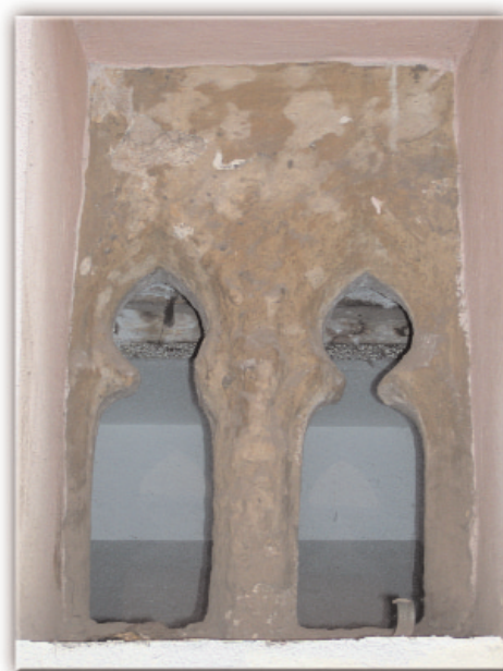
Ventana gótica de la Casa de los Cabero, fachada Calle Maestro Copín.
