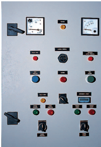
8. FRENTE DEL CUADRO DE CONTROL, MANDO Y PROTECCIÓN DEL GRUPO DE PRESIÓN DE LAS BIE.
