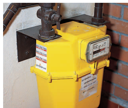
21. CONTADOR INDIVIDUAL Y LLAVE DE CORTE.
