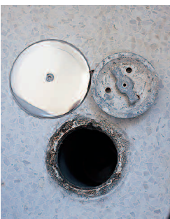
10. BOTE SIFÓNICO CON TAPA DESMONTADA.
