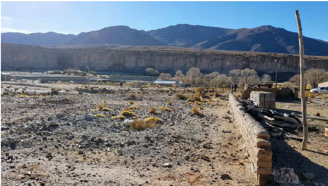
Panorámica desde el CDIA a construir.
