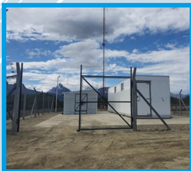
Figura 2: contenedores que alojan los equipos de comunicaciones
