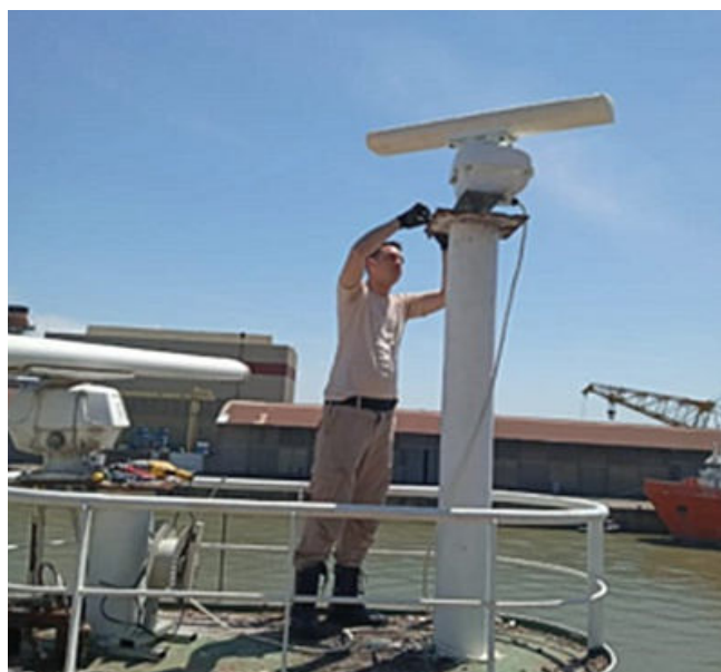
Figura 7: proceso de instalación del radar
