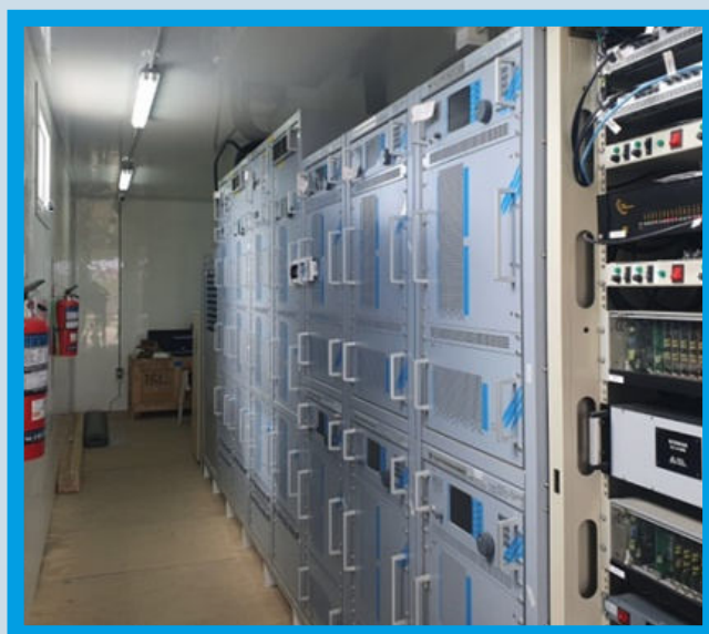
Figura 3: vista interior de uno de los contenedores
