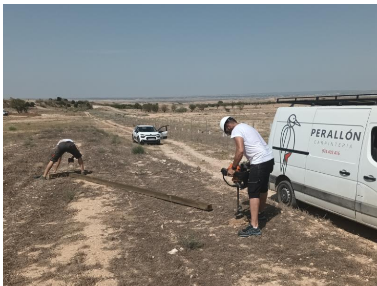
Instalación de una de las perchas en el proyecto.
