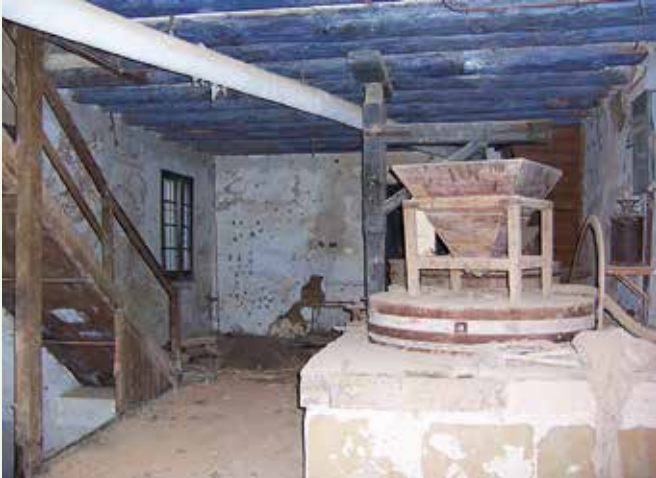
Buena parte de la maquinaria de La Fábrica se conserva en buen estado (Autor: SIPCA)
