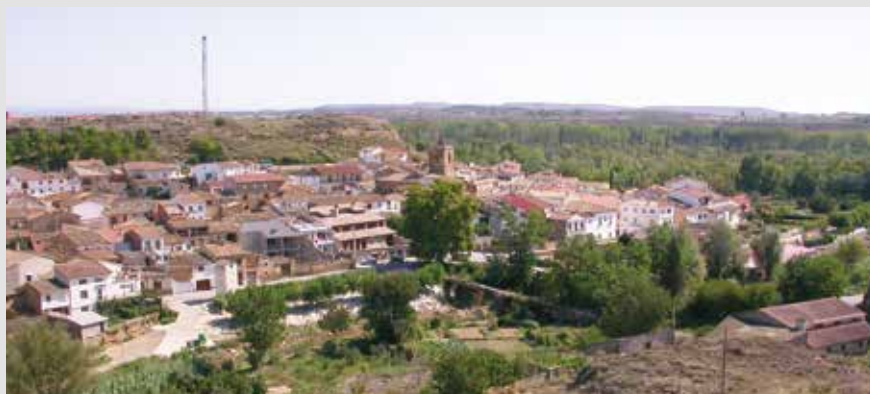
Vista general de Pomar de Cinca
