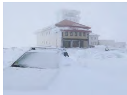
Figura 13.21. Fotografía de la acumulación de nieve registrada en el observatorio el 8 de febrero de 2018.
