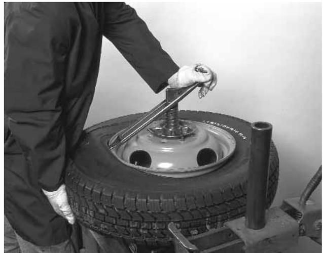
**NO INFLAR EL NEUMÁTICO A MÁS DE 40 PSI PARA SENTAR/COLOCAR LAS CEJAS DE ÉSTE.** Si las cejas del neumático no se han sentado/colocado a 40 psi, extraer el aire y volver a lubricarlos. Fijese que el tamaño del neumático y del rin correspondan/encajen y que no existan interferencias entre las mismas.
