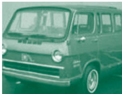
La aplicación del hidrógeno a la automoción tiene sus orígenes en 1967 cuando la General Motors saca la furgoneta Electrovan, ver foto, con un peso de 3.400 Kg.,
