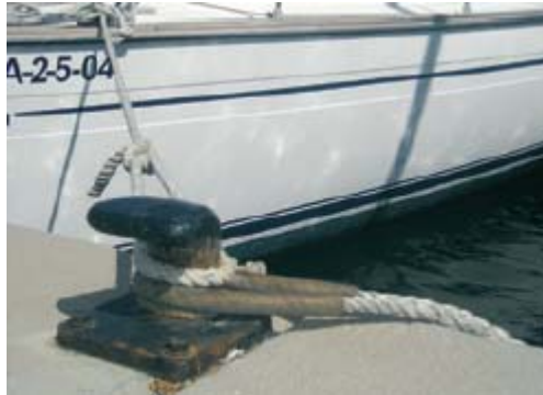
Figura 3.52- Noray. Fuente: Propia
