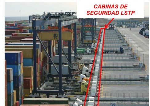
Fotografía tomada por Best. Cabinas de seguridad.
