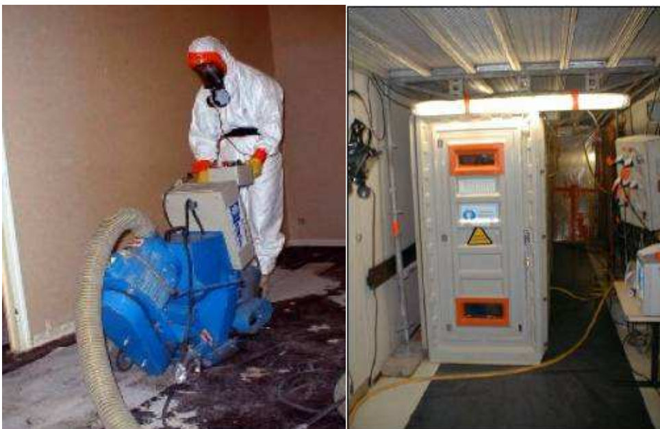
Fig. 8.1. Equipamiento utilizado para retirar amianto
