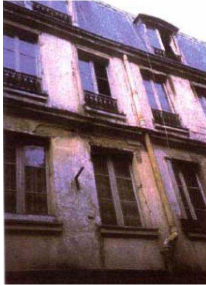
Fig. 4.2. Fachada de construcción de antes de 1850
