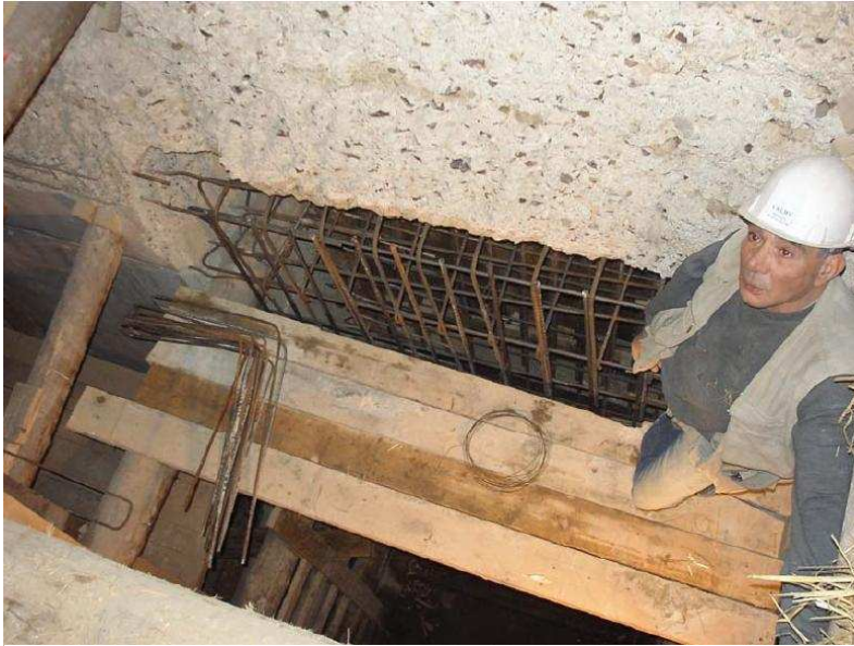
Fig. 5.17. Colocación de armaduras debajo de una pared existente
