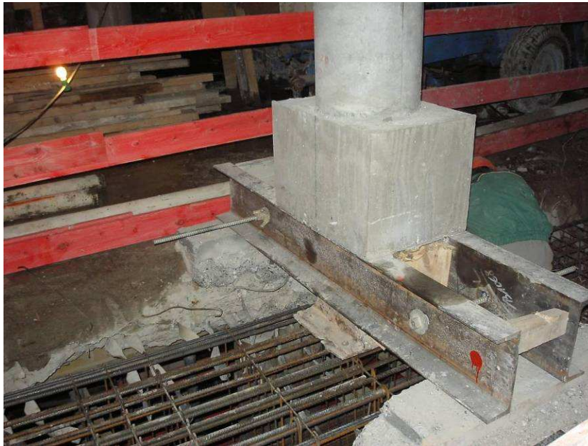
Fig. 5.11. Colocación de armaduras de la futura viga
