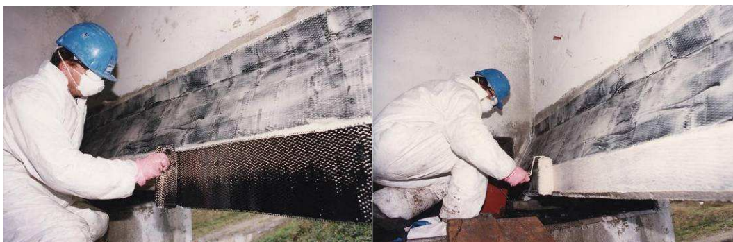
Fig. 5.31. Consolidación por fibras de carbono
