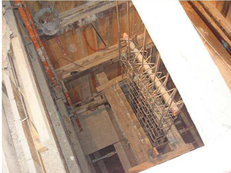
Fig. 5.14. Colocación de las armaduras del futuro pilar
