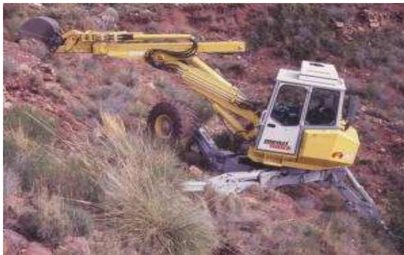
Figura 2.1.2.5.1. Retroaraña ahoyando en una ladera (Fuente: Serrada, 2000)
