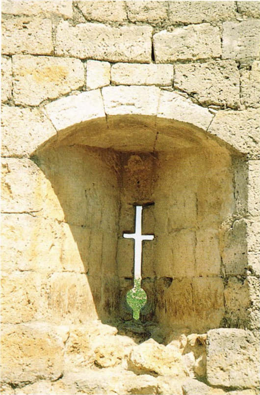
Fig. 70.- Cubete artillero de Astudillo (Palencia). Cámara de tiro pirobalístico en el cuerpo superior del cubete, mostrando una tronera de cruz y orbe. El cuerpo inferior está dotado de cañoneras con acusado abocinamiento exterior, y por tanto sin cámara de tiro en el grosor del muro. Debió ser labrado por los Condes de Castrojeriz hacia 1500, como refuerzo de una fortaleza preexistente en La Mota de Astudillo, hoy virtualmente desaparecida.
