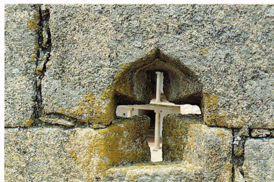
Fig. 261.- Castillo de Oropesa (Toledo). La misma muestra, desde una de las troneras cruciformes del antepecho, que proporciona un ángulo de visión más propio de una mirilla que de un vano pirobalístico, generando gran espacio muerto en los aproches inmediatos.
