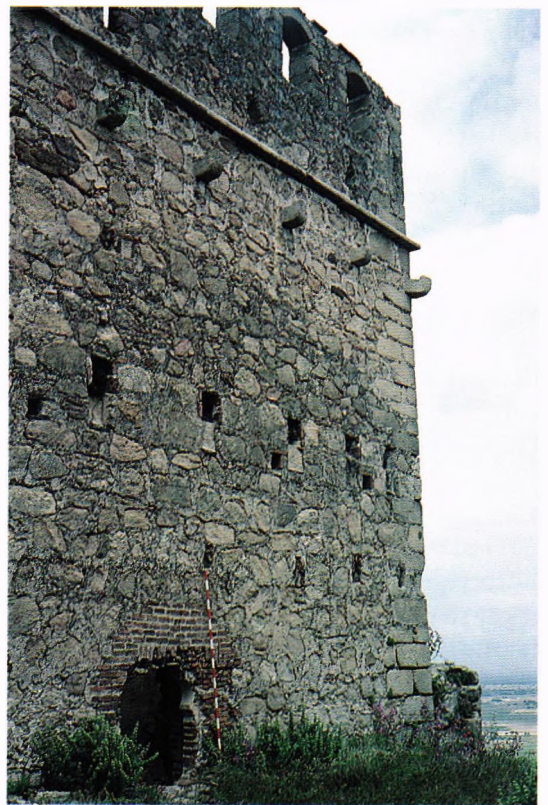
Fig. 66.- Castillo de Belvis de Monroy (Cáceres). Mechinales y canecillos para montar un cadahalso en la torre del homenaje, a media altura. Pudiera ser obra de los años centrales del siglo XV.
