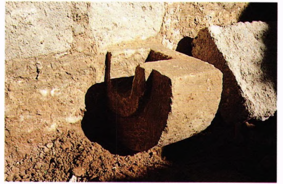
Fig. 185.- Castillo de Santiago (Sanlúcar de Barrameda, Cádiz). Ranga horizontal para el eje de un puente izable entre el «aula maior» y el sector noreste de la liza, de hacia 1478.
