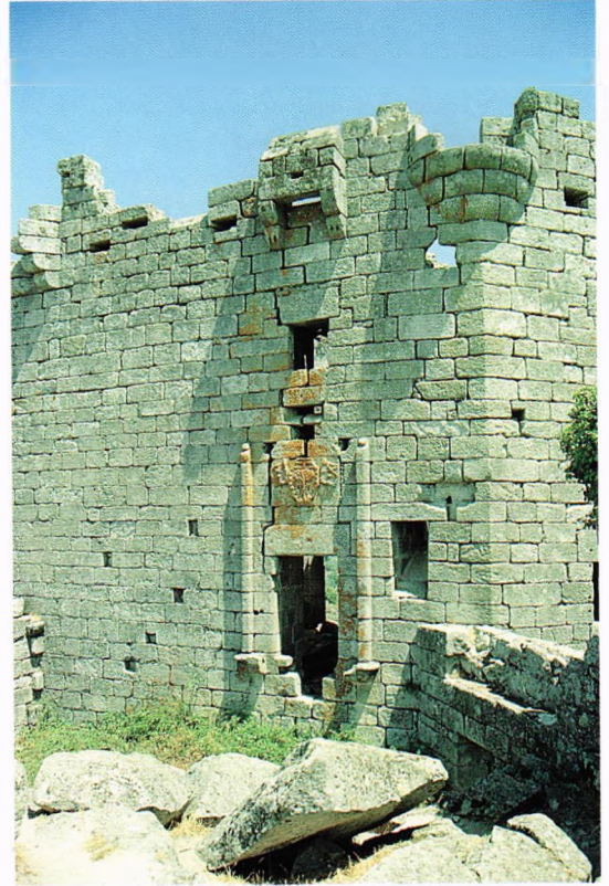
Fig. 190.- Castillo de Trevejo (Cáceres). Puente izable para acceder a la torre del homenaje desde el recinto alto. Las dos pilastras encastraban el puente izado y flanquean las armas del Comendador Mayor Juan Piñeyro, de la Orden de San Juan de Rodas que lo está labrando en 1514.
