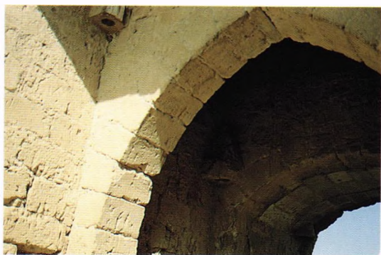
Fig. 192.- Castillo de Trigueros del Valle (Valladolid). Arquería y ranguas de los tres portajes sucesivos en el pasaje de acceso de la torre-puerta, labrada por los Robles-Guevara en 1453 y que no debió verse afectada substancialmente por las algaradas de vasallos en 1521, a diferencia de la falsabraga que tuvo que ser reconstruida cinco años después.
