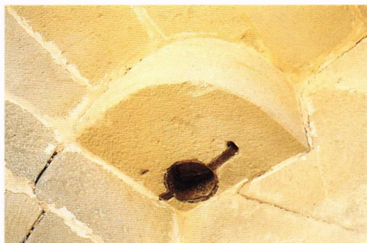
Fig. 191.- Castillo de Almenar (Soria). Rangua de un portón en la falsabraga, con casquillo de hierro embutido para paliar el desgaste de los gorriones con el giro de las pesadas hojas. Corresponde a las controvertidas reformas introducidas por el Comendador Gonzalo de Beteta hacia 1490.
