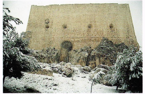
Fig. 77.- Castillo de Vélez Blanco (Almería). Cuatro cañoneras de abocinamiento exterior troncocónico, abiertas en el frente meridional de la antepuerta artillada, batiendo parte de la población y algún padastro de las estribaciones de Sierra María. Construida hacia 1507 por los Marqueses de los Vélez, la fortaleza es excepcional por varios conceptos, principalmente por la estudiada compartimentación de la defensa.
