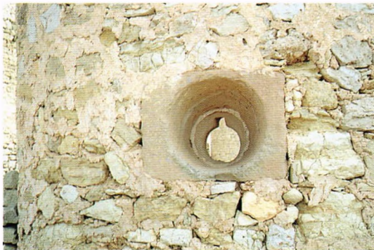
Fig. 5.- Castillo de Caracena (Soria). Tronera con abocinamiento troncocónico externo en uno de los cubos de flanqueo de la antepuerta, de hacia 1495.
