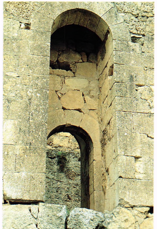
Fig. 59.- Castillo de Paracuellos de la Vega (Cuenca). Buhedera en la torre del homenaje pentagonal en proa, de hacia 1300.
