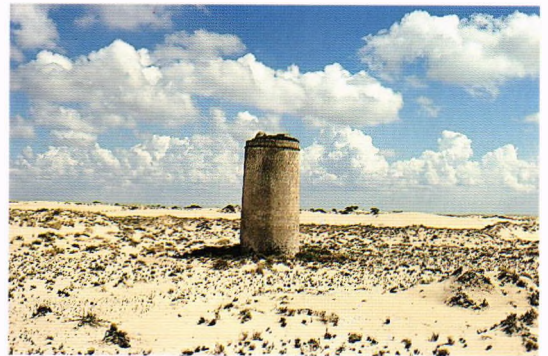
Fig. 238.- Torre de almenara de Zalabar (Coto de Doñana, Huelva). Aunque erigida según el proyecto de Luis Bravo de Lagunas, de 1577, responde a una morfología bastante atemporal, la de un estilizado cubo de mampostería con acceso elevado y terrado de observación; modelo estrictamente funcional y consagrado por la experiencia desde, al menos, las atalayas altomedievales de la meseta castellana. El litoral onubense estaba muy castigado por los golpes de mano de pequeñas partidas de corsarios berberiscos, con una bajísima densidad demográfica y sus escasos vecinos empobrecidos por el pago de los rescates. Incluso el comisionado de Felipe II aludido más arriba, cuando recorre y examina la costa entre Marzo y Agosto de 1577, informa al Presidente del Consejo de Guerra: «mi jornada ... sera trabajosa porque no puedo caminar sino en medio de la siesta por andar ya todo esto lleno de navios enemigos y no poderse caminar por esta costa sin reconocerla primero, que todo el peligro está en las mañanas y las noches ...». La visión que ofrece esta modesta almenara desde el mar, asentada en una zona dunar más o menos fijada con esporádica vegetación de camarina, barrón y alguna raquítica abulaga, guaita silente, debió aliviar algo la angustia de los exiguos nativos que faenaban el litoral y su ominoso panorama vital, que ya las Cortes de Toledo de 1538 reconocían al reclamar que «desde Perpiñán a la costa de Portugal y las tierras marítimas se están incultas, bravas y por labrar y cultivar, porque a cuatro o cinco leguas del agua no osan las gentes estar ...» (Fotog. de 1976).
