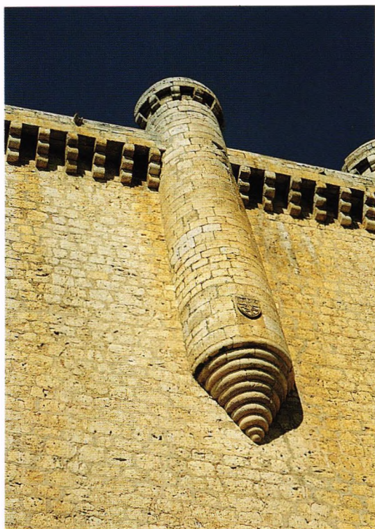
Fig. 108.- Castillo de Torrelobatón (Valladolid). Estilizada escaraguaita en esta fortaleza de los Almirantes de Castilla, de lámpara abocelada y sobre ella las armas de los Enríquez.
