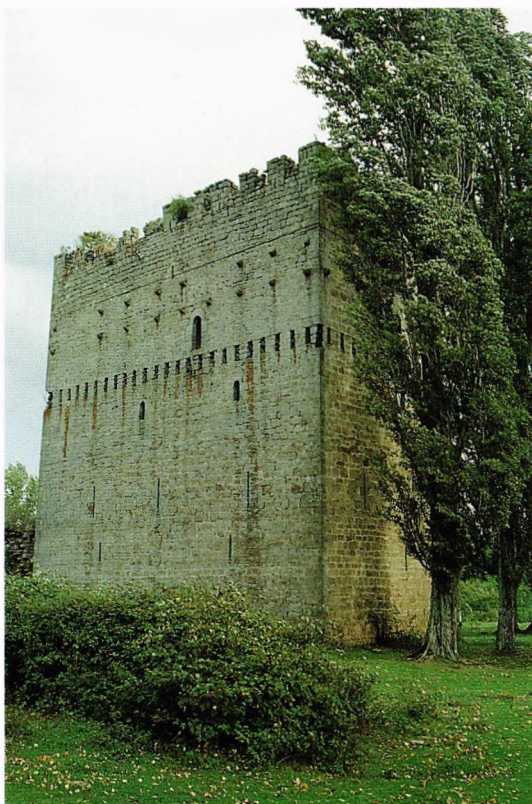
Fig. 254.- Torrona de los Velasco (Espinosa de los Monteros, Burgos). Construida probablemente en la primera mitad del siglo XV por el Conde de Haro, muestra los mechinales y canecillos de un cadahalso perimetral. Quizás quedaba inhabitable en Noviembre de 1808, tras las gravosas operaciones del Duque de Bellune en Espinosa de los Monteros.
