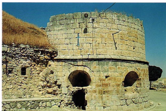
Fig. 94.- Cubete artillero de Astudillo (Palencia). La casamata dispone de dos niveles de fuego, el inferior para artillería ligera y el superior para armas portátiles, y debió ser labrada hacia 1500 (Ver fig. 70).
