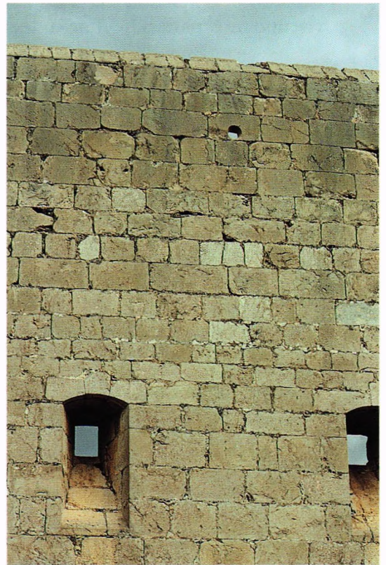
Fig. 6.- Castillo de Mula (Murcia). Cañoneras con abocinamiento externo, de leve deriva y acusado derrame inferior, de hacia 1523.
