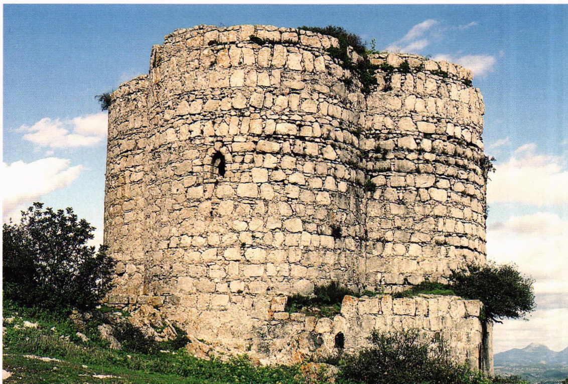
Fig. 102.- Castillo de Cotte (Sevilla). El donjón-capilla desde el suroeste, mostrando tres de los ábsides que configuran su excepcional planta tetrabsidal, sobre un plinto achaflanado. Sus muros, gruesos y casi ciegos, sostienen una airosa conjunción de bóvedas góticas con fina nervadura de piedra franca y plementería latericia. Sus cualidades defensivas son meramente pasivas, además de las inherentes a su emplazamiento al borde de un acantilado, en las estribaciones del serrijón de Pancorbo. Probablemente fue construido en el último tercio del siglo XIII por la Orden de Alcántara, en la cota superior de un modesto ma'āqil islámico quizás despoblado tras la revuelta mudéjar de 1264.
