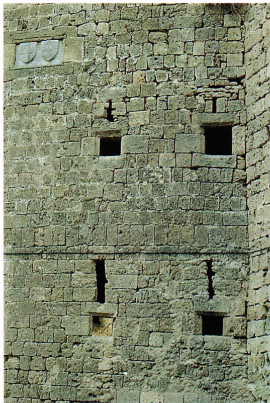
Fig. 262 y 263.- Castillo de Caracena (Soria). Vista interior y exterior de sendas troneras abiertas en la falsabraga, sector que corresponde a la controvertida etapa constructiva de don Alfonso Carrillo de Acuña, en la última década del siglo XV. Las cañoneras (ver fig. 73) y troneras de esta fortaleza soriana, como en tantos otros casos, están ubicados sin tener para nada en cuenta la topografía de los aproches, los ángulos de tiro, ni la inevitable secuela de espacios muertos, aunque el diseño formal de sus aberturas sea funcionalmente tan afortunado como estadísticamente infrecuente.
