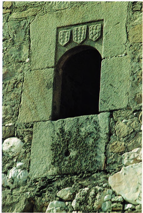
Fig. 270.- Torrona de Cespedosa de Tormes (Salamanca). Ventana aspillerada con tronera de «palo y orbe» en la tercera de las cuatro plantas de esta arcaica, o quizás arcaizante, torrona de exigua superficie y tosca y abundante heráldica con roeles de Dávilas y bezantes de Sarmientos en equívoca indefinición. Dispone de ladroneras en sus cuatro caras y muestra tendencia hacia el megalitismo como simplificación estereotómica, percibiéndose en la imagen que el arco escarzano, su arrabá y la albanega blasonada son en realidad un dintel monolítico de granito, al igual que el alféizar, y antepecho aspillerado.
