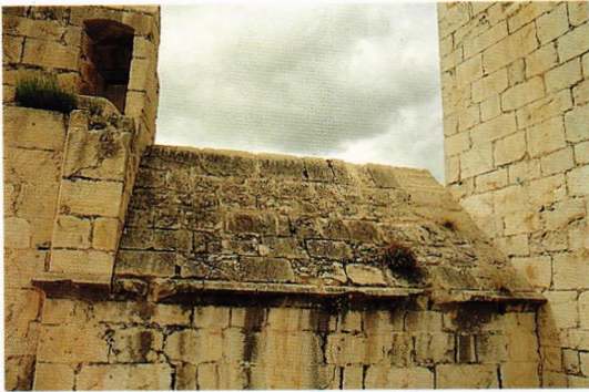
Fig. 200.- Castillo de Mula (Murcia). Rampa de compartimentación entre el adarve septentrional y la torre del homenaje, prevista desde el diseño inicial de la fortaleza, construida por el Marqués de los Vélez hacia 1524 con buena estereotomía, y por tanto no el producto de una reforma posterior, como en Sanfelices de los Gallegos o en Montalbán.
