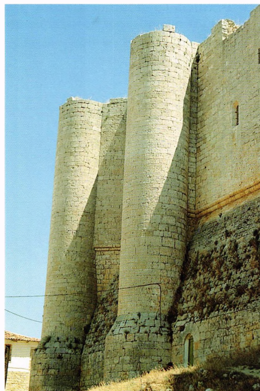
Fig. 55.- Castillo de Fuentes de Valdepero (Palencia). Dos de los ocho borjes-contrafuerte de la enorme y desmochada torre del homenaje, construida para el Conde de Santa Marta en el último tercio del siglo XV.
