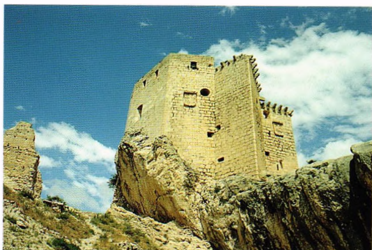
Fig. 113.- Castillo de Mula (Murcia). Esperonte en el costado occidental, que también sostuvo un adarve amatacanado, de hacia 1520. Es el único en esta fortaleza de los Marqueses de los Vélez, cuyo áspero emplazamiento no permitía mayor simetría.
