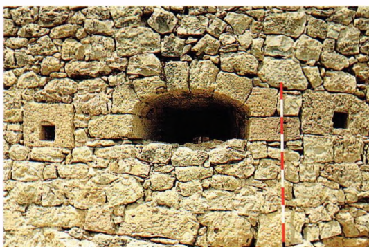
Fig. 75.- Castillo de Cardenete (Cuenca). Abocinamiento exterior de una cañonera de hacia 1524, en esta pequeña fortaleza intensamente artillada, concebida aunque inacabada por el segundo Marqués de Moya.
