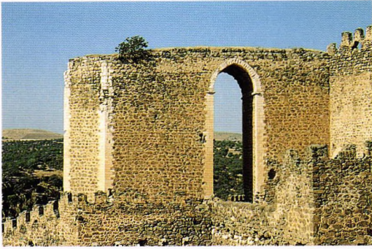
Fig. 250.- Fortaleza de Montalbán (Toledo). La torre albarrana meridional, de planta pentagonal en proa, precedida de un sector de la falsabrega. Constituye, junto con su contigua y mejor conservada torre del homenaje, la combinación de pentagonal en proa y albarrana más disuasora de entre las que se han conservado en la castrametación medieval, siendo ambas obra bastante probable de don Juan Manuel hacia 1323, en los años en los que, siendo menor Alfonso XI y habiendo muerto doña María de Molina, se intitulaba Regente en las tierras toledanas y extremeñas, aunque sin la menor paz posesoria; por entonces Montalbán era fortaleza de realengo, desde que pocos años atrás fuera encomienda templaria confiscada por la Corona y su Comendador, Frey Lope Fernández, muriera prisionero del Arzobispo de Toledo.
