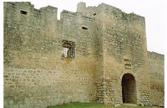
Fig. 251.- Castillo de Trigueros del Valle (Valladolid). Somera torre-puerta que apenas flanquea los lienzos contiguos, limitándose a cobijar un corto pasaje de acceso directo con tres arcos y portajes sucesivos (ver fig. 192). Según testimonio epigráfico y heráldico fue construida por los Robles-Guevara en 1453, aunque las troneras de «buzón» y la ventana enrejada en el lienzo lateral deben ser bastante posteriores, correspondiendo quizás a la tercera década del siglo XVI, cuando don Gutierre de Robles repara y acondiciona las defensas destruidas por los comuneros.
