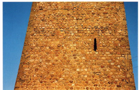
Fig. 41.- Muralla de Villalpando (Zamora). Torre de la muralla urbana que pudiera ser levantada en la segunda mitad del siglo XII por Fernando II de León, o cien años después por el Temple, aunque quizás esta Orden sólo labrara la Iglesia de Santa María del Temple en dicha encomienda. El aparejo de la torre está formado con gruesos guijarros de cuarcita, extremadamente duros aunque de mal asiento, y los vivos perfilados con sillares y ladrillos.
