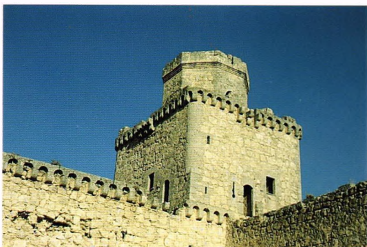
Fig. 89.- Castillo de Barciene (Toledo). Construido por los Silva hacia 1469, compartimenta su defensa a nivel de los adarves por medio de las torres esquineras, cuyos accesos se guarnían de troneras de palo y orbe así como de ladroneras.
