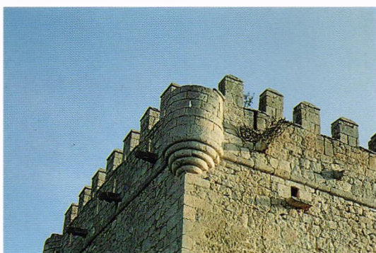
Fig. 151.- Torrona de Quintana de Valdivielso (Burgos). La torrona de Loja debió ser labrada hacia 1500 por los Saravia-Beñé, aprovechando estructuras preexistentes del segundo de los linajes. La merlatura muestra la atrofia característica de su estadio evolutivo, al tiempo que las escaraguaitas de esquina han venido en verdaderas garitas.
