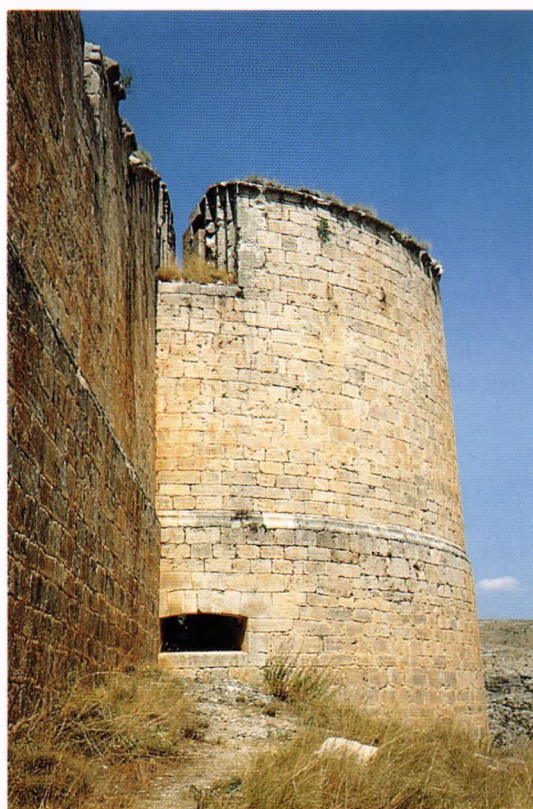
Fig. 76.- Castillo de Berlanga de Duero (Soria). Cubo noreste, sobre el despeñadero del Bordecorex, mostrando abajo una cañonera de buzón y arriba una almena artillera con deriva escalonada, obra probable de Benedetto de Rávena para los Duques de Frías, poco antes de 1528 en que se abandona la construcción de esta nueva fortaleza artillada que envolvía la tardo-medieval de los Tovar.
