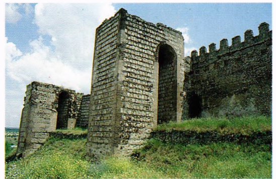
Fig. 233. Fortificaciones de Escalona (Toledo). Dos torres albarranas de flanqueo en el sector septentrional de la fortaleza, que aún conserva otras cinco similares, todas ellas atribuidas a don Juan Manuel (c. 1321-1325), aunque con recrecimientos aspilleros para la pirobalística del siglo XV, obra probable de la etapa de don Alvaro de Luna (1424-1453). Las tierras de Toledo resultan sorprendentemente abundosas en torres albarranas de flanqueo, encontrándose también en la cerca urbana de Talavera de la Reina o en la gran fortaleza de Montalbán, con apreciaciones cronológicas que abarcan de Alfonso VIII de Castilla (1156?-1158/1214) a don Juan Manuel (1282-1348), y que en estos dos lugares presentan además planta pentagonal en proa, otra rareza castral que se prodiga en la cuenca del Tajo.
