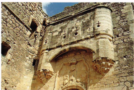
Fig. 131.- Castillo de Garcimuñoz (Cuenca). Amplia ladronera sobre el acceso principal, obra probable del Marqués de Villena a mediados del siglo XV, y en cuyas proximidades murió combatiendo don Jorge Manrique Figueroa en 1477.
