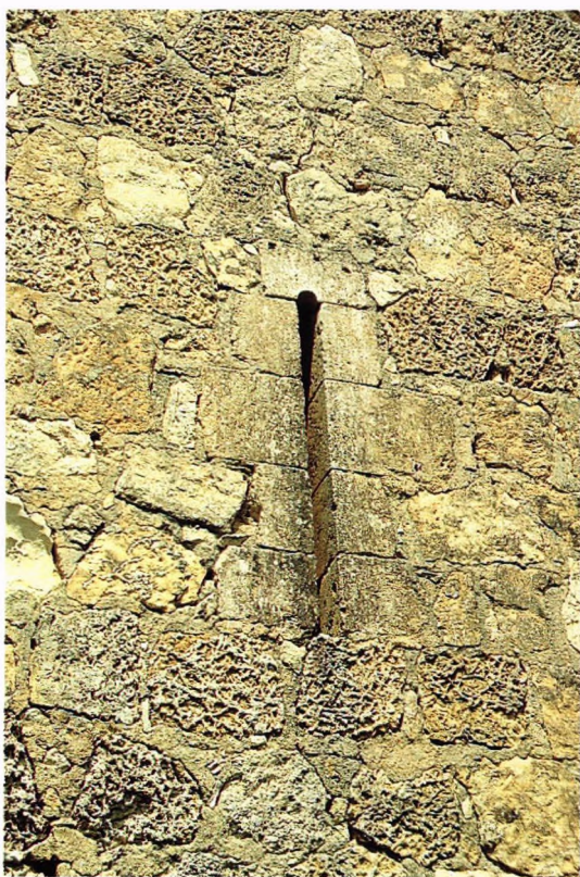
Fig. 216.- Castillo de Paracuellos de la Vega (Cuenca). Tragaluz, con apariencia exterior de saetera, en la torre del homenaje pentagonal en proa de esta fortaleza episcopal de hacia 1300.
