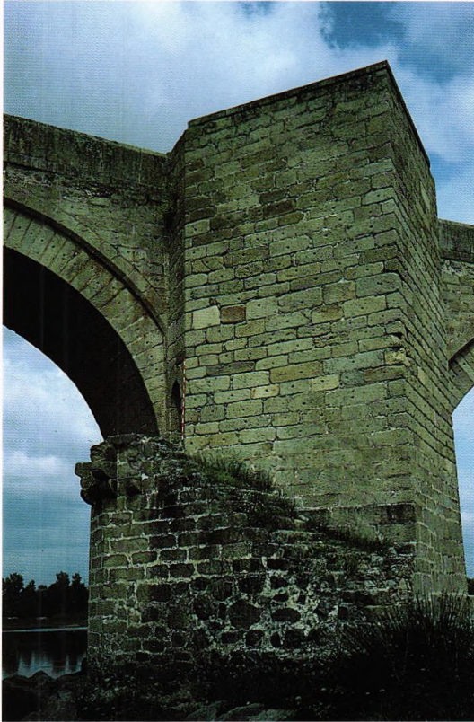
Fig. 180.- Puente del Arzobispo (Toledo). Pilar y contratajamar donde se levantaba la torre de la margen izquierda, mostrando el embarcadero amatacanado y escalonado que se agrega en el siglo XV. Las nueve hiladas superiores del contratajamar, sin muescas para la tenaza elevadora, es un añadido que recreó su terrado original.
