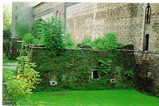
Fig. 103.- Castillo Sforzesco (Milán). Hoy bastante restaurado, tiene su origen en la reconstrucción de Francisco Sforza, hacia 1450, de una nueva fortaleza sobre los restos de otra anterior, de los Visconti. En la imagen, el durmiente de un puente levadizo peatonal, con el nivel inferior en funciones de caponera.
