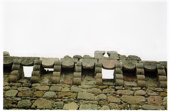
Fig. 145.- Iglesia-castillo de Turégano (Segovia). Matabanes sobre modillones, con faldón protector semicircular y diferente grado de derrame en el abocelado, para permitir el hostigamiento oblicuo además del vertical. Ha perdido casi todo el antepecho que sustentaba, aunque aun se detecta que dispuso de troneras, probablemente de «cruz y orbe». Corresponde al sector de la torre del homenaje, labrado por el Obispo don Juan Arias Dávila entre 1463 y 1490, aunque los matabanes de este sector pudieron ser rehechos en el pontificado de don Juan Arias del Villar, entre 1498 y 1501.
