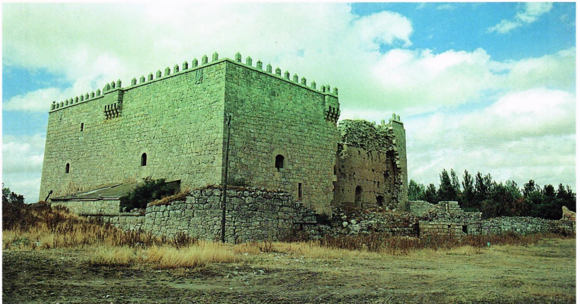
Fig. 79.- Casa-fuerte de Hormaza (Burgos). Parecen distinguirse dos etapas de construcción, ambas de la familia Castañeda. En primer lugar, podría corresponder a mediados del siglo XV el cuerpo central, cuadrangular, de gruesos muros con núcleo de tapial y forro de sillería de un metro de espesor, y en segundo lugar a comienzos del XVI la poderosa y destrozada falsabraga, así como la tenue y simbólica merlatura del cuerpo central. La refortificación, anterior a 1517, fue obra del matrimonio Castañeda-Zúñiga.
