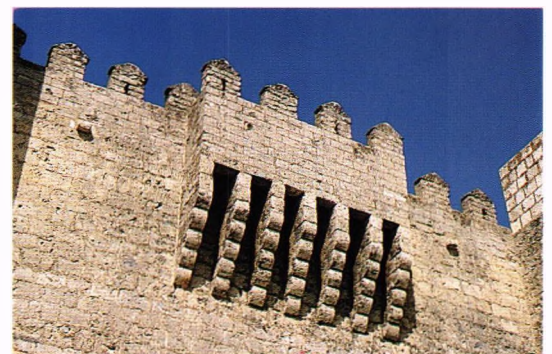
Fig. 133.- Castillo de Montalegre (Valladolid). Gran ladronera sobre el acceso principal, junto a la torre del homenaje de planta pentagonal en proa, en un conjunto fechable hacia mediados del siglo XIV.
