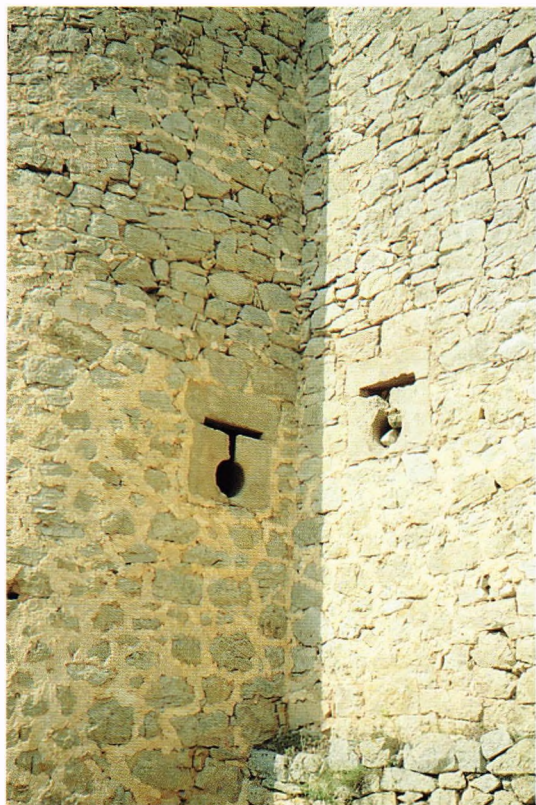
Fig. 262 y 263.- Castillo de Caracena (Soria). Vista interior y exterior de sendas troneras abiertas en la falsabraga, sector que corresponde a la controvertida etapa constructiva de don Alfonso Carrillo de Acuña, en la última década del siglo XV. Las cañoneras (ver fig. 73) y troneras de esta fortaleza soriana, como en tantos otros casos, están ubicados sin tener para nada en cuenta la topografía de los aproches, los ángulos de tiro, ni la inevitable secuela de espacios muertos, aunque el diseño formal de sus aberturas sea funcionalmente tan afortunado como estadísticamente infrecuente.
