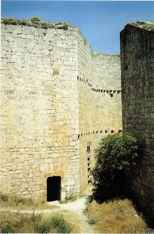
Fig. 50.- Castillo de Berlanga de Duero (León). Cubo artillado del ángulo noroeste desde el interior del sector reformado por la casa de Frías, e inacabado tras la muerte de los segundos Duques en 1528. Los mechinales para la viguería sugieren unas techumbres incapaces de soportar la artillería prevista a juzgar por las cañoneras con deriva escalonada características de esta fortaleza. Aunque bestorre, la planta baja muestra adarajas para un muro de cierre por la gola nunca construido.
