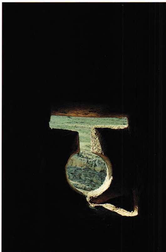
Fig. 262 y 263.- Castillo de Caracena (Soria). Vista interior y exterior de sendas troneras abiertas en la falsabraga, sector que corresponde a la controvertida etapa constructiva de don Alfonso Carrillo de Acuña, en la última década del siglo XV. Las cañoneras (ver fig. 73) y troneras de esta fortaleza soriana, como en tantos otros casos, están ubicados sin tener para nada en cuenta la topografía de los aproches, los ángulos de tiro, ni la inevitable secuela de espacios muertos, aunque el diseño formal de sus aberturas sea funcionalmente tan afortunado como estadísticamente infrecuente.
