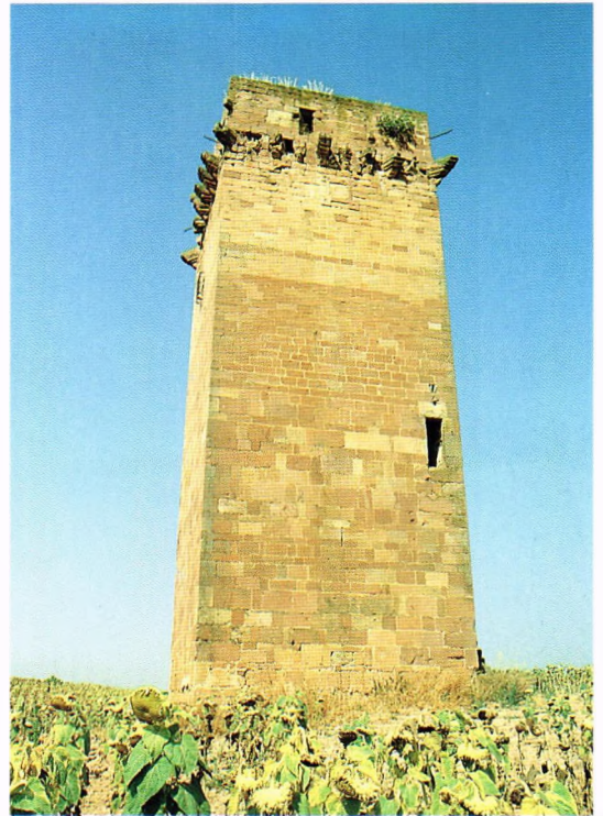
Fig. 65.- Torre de Villaverde (Montoro, Córdoba). Torre de la campiña reconstruida por don Diego de Aguayo hacia 1472, mostrando en su coronación los canecillos para un cadahalso perimetral.
