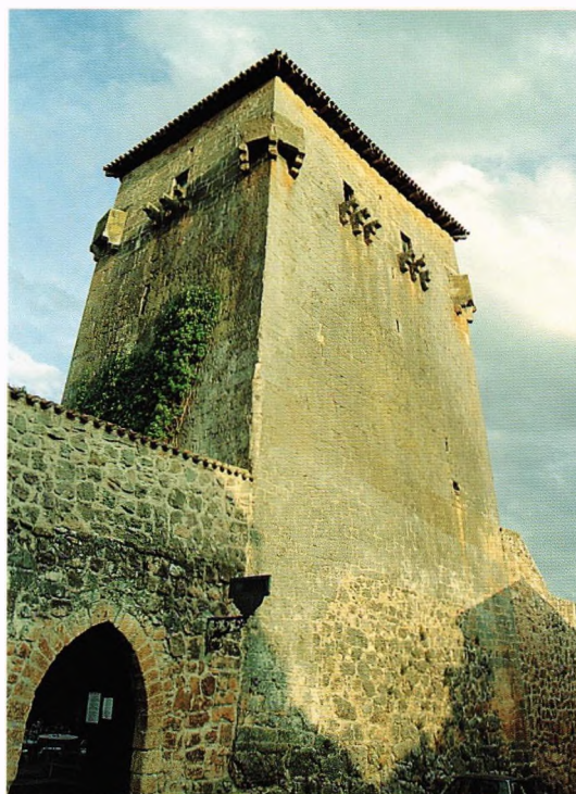
Fig. 222.- Torre de Covarrubias (Burgos). Cuerpo troncopiramidal probablemente del siglo X, aunque con añadidos bastante posteriores como las diez ladroneras de fines del XIV, el patín de acceso a la segunda planta o la techumbre a cuatro aguas.
