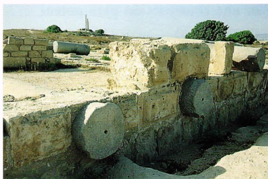
Fig. 42.- Castillo de Saranda Kolones (Pafos, Chipre). Construido por los Lusignan hacia 1198 y abandonado tras el desastroso terremoto de 1222, Saranda Kolones ofrece un uso sistemático de las columnas perpiañas a modo de llave que cose los paramentos y el migajón de los muros, particularmente en el sector suroeste del recinto exterior y en la torre-puerta semicircular del interior. Ese medio centenar de recias columnas de granito, que dan nombre a la fortaleza, procedían de las ruinas de edificios públicos romanos del área de Nea Pafos.
