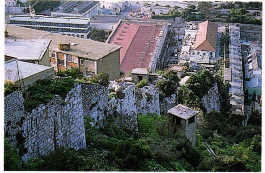
Fig. 165.- Alcazaba de Gibraltar. Muralla en zigzag flanqueante en el frente noreste, descendiendo desde La Calaborra hasta el tránsito del istmo y la antigua línea costera de la bahía (ver fig. 34). Debe ser el resultado de una intensa refección de los siglos XVI y XVII sobre lienzos del XIV, según proyectos en los que intervinieron Benedetto de Rávena, Calvi, Fratino, los Antonelli, Spanochi, Rojas o Bravo de Acuña, obras castigadas en sucesivos asedios, y en particular el decimocuarto, de 1779 a 1783, con intensa actividad artillera.
