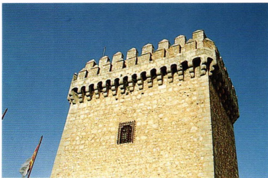
Fig. 21.- Castillo de Alarcón (Cuenca). Adarve colgado en la torre del homenaje, obra fechada hacia 1400.
