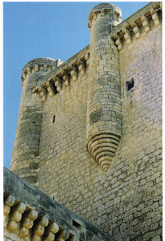
Fig. 2.- Castillo de Torrelobatón (Valladolid). Parapeto abocelado sobre matacanes cegados, probablemente algo posteriores al cerco de Juan de Padilla y sus comuneros en Febrero de 1521.
