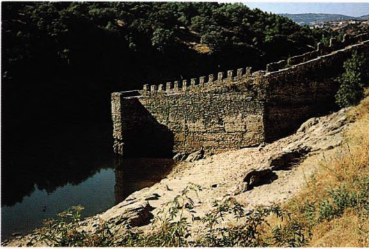
Fig. 92.- Castillo de Buitrago de Lozoya (Madrid). La coracha que partiendo del ángulo sureste de la fortaleza penetra en las márgenes del río Lozoya, para procurarse aguada protegida en caso de asedio y, quizás, amparar un puente próximo hoy destruido y anegado. El hecho de disponer de parapeto sólo en el costado meridional parece indicar que otra protección descartaba el hostigamiento por el sur, que en cualquier caso era un flanco encajonado entre el lienzo oriental del castillo y la orilla derecha del Lozoya. La coracha en cuestión parece ser obra anterior a las reformas de los Mendoza, a cuyo linaje pasa Buitrago a mediados del siglo XIV.
