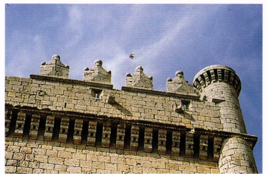
Fig. 146.- Castillo de Belmonte de Campos (Palencia). Matabanes a modo de entablamento clásico, impregnado de un aire renacentista adquirido por su enigmático dueño y constructor, don Juan Manuel, como Embajador del Emperador Maximiliano I en Roma algunos años antes de su inacabada edificación hacia 1527. La escaraguaita aloja un «caracol de Mallorca», en el que en esos años se iniciaba Andrés de Vandelvira.
