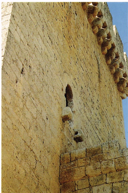
Fig. 187.- Castillo de Villalonso (Zamora). Puente retráctil entre la torre del homenaje y el adarve noreste, de hacia 1470.
