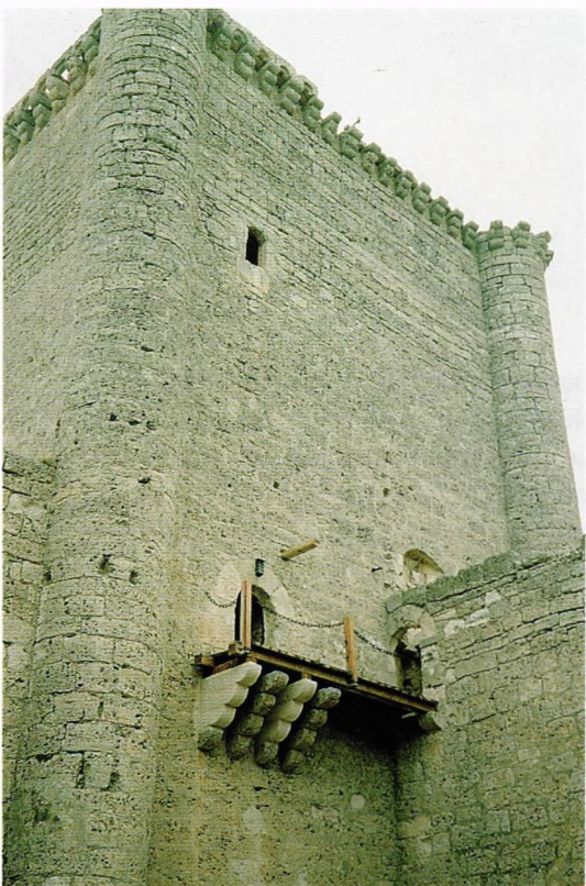
Fig. 89.- Castillo de Barciene (Toledo). Construido por los Silva hacia 1469, compartimenta su defensa a nivel de los adarves por medio de las torres esquineras, cuyos accesos se guarnían de troneras de palo y orbe así como de ladroneras.
