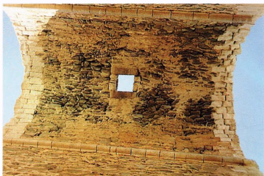
Fig. 60.- Fortaleza de Montalbán (Toledo). Buhedera interior en el intradós del arco de la torre albarraña meridional, obra probable del primer tercio del siglo XIV.
