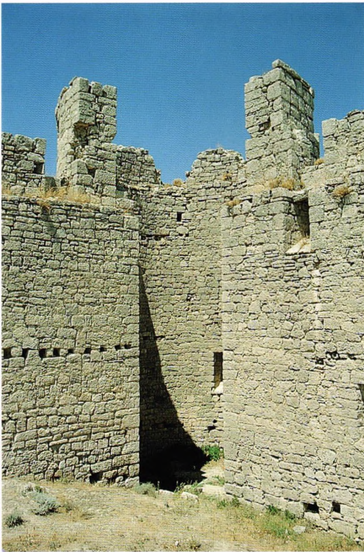
Fig. 224.- Castillo de Hornillos del Cerrato (Palencia). Probablemente labrado hacia 1500 por el Conde de Ribadeo, ofrece la misma incongruente debilidad de forjados para soportar la artillería de la época que se detecta en Berlanga de Duero (ver fig. 50). Pudiera estar igualmente inacabado.
