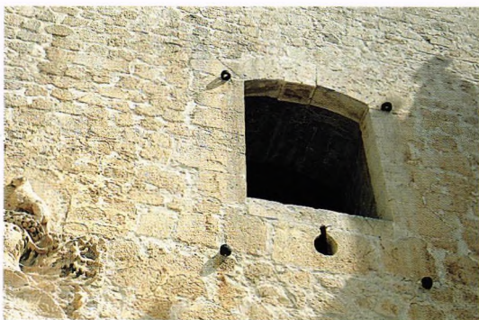
Fig. 271.- Castillo de Vélez Blanco (Almería). Ventana aspillerada en el lienzo suroeste, sobre el acceso principal, el sector mejor protegido por tener más probabilidad de hostigamiento. El jambaje conserva aún los cuatro goznes de hierro para unas contraventanas exteriores blindadas, que presenta la limitación de condenar al cerrarse la tronera de «palo y orbe» del alféizar, neutralizándola. Primera década del s. XVI
