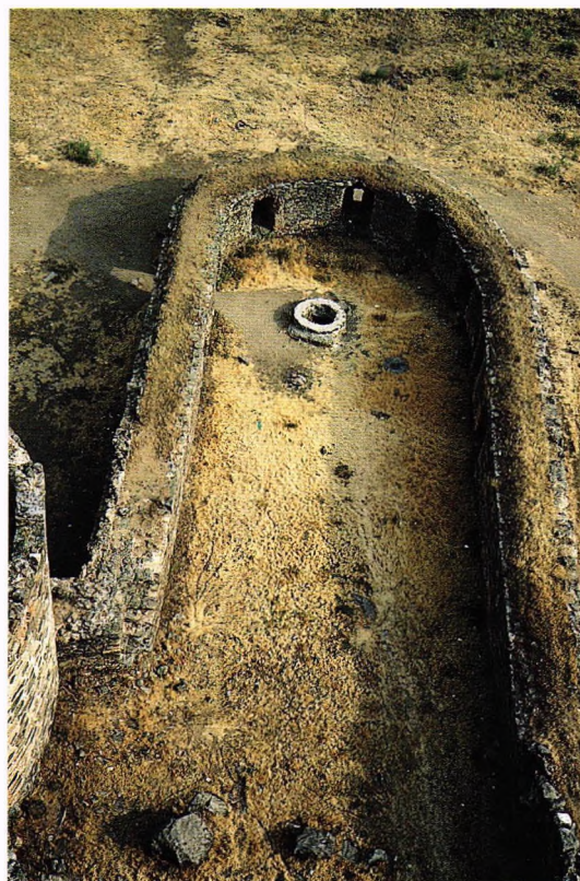
Fig. 91.- Fortaleza de Montalbán (Toledo). Coracha envolvente de un pozo de aguada, vista desde el adarve de la torre albarrana meridional, que la domina, al igual que la bestorre artillada que se insinúa a la izquierda de la imagen. La muralla de la coracha tiene algo más de dos metros de grueso por tres de alto, sobre la que corre un camino de ronda cuyo antepecho ha desaparecido, y cuya base está perforada por troneras circulares que cubren la rambla sangrada por el pozo en todas direcciones. Extrañamente, su único acceso visible no es por la liza, de la que arranca la coracha, sino por el campo abierto, como si el uso del pozo tuviera que ser compartido con el exterior, y se prefiriera no tener que dejar penetrar a los aguadores por la fortaleza. El pozo en cuestión, en la cabeza exterior de la coracha, enmarca su boca con un brocal circular moderno, aunque la sección del mismo sea rectangular (220 x 125 cms), sugiriendo la existencia original de una noria. Su profundidad actual es de diez metros, y a cinco de la boca parte una galería subterránea hacia la albarrana meridional, mina de aguada hoy obstruida por desprendimientos. La aguada debió ser una preocupación constante, como en tantas otras fortalezas, y nos consta que en 1420, refugio del Rey niño Juan II, y en 1462, de la airada viuda de don Alvaro de Luna, la aguada fue el factor decisivo en la ocupación del castillo, por casualidad o por fatalidad dolosa.
