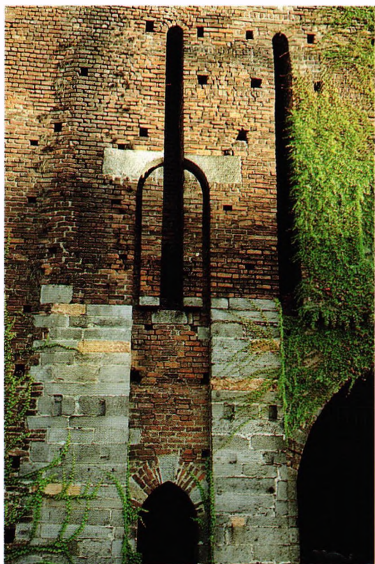
Fig. 173.- Castillo Sforzesco (Milán). Portillo y el rebundido para el encastre de su puente peatonal, del tipo levadizo por cigoñal, de hacia 1450.
