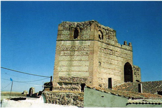
Fig. 234.- Muralla urbana de Madrigal de las Altas Torres (Ávila). Una de las torres de flanqueo, albarrana y pentagonal en proa, como la occidental de la Puerta de Cantalapiedra, en la misma cerca, que debía estar recién construida en 1302 cuando la ciudad de Arévalo apeló a Fernando IV para que autorizara el derribo de esta muralla labrada sin la autorización del Concejo arevalino, a cuyo alfoz pertenecía. Burgo de llanura, la cerca adopta una infrecuente planta aproximadamente circular, y aunque se perciben varias etapas de construcción, el conjunto ofrece un aspecto gótico-mudéjar relativamente homogéneo, con la pobreza material y riqueza formal características. A mediados del siglo XIX aún conservaba medio centenar de torres y amplio sectores de lienzos y falsabraga, sin haber padecido además la actual "merlonitis" de guardarropía que la caricaturiza.
