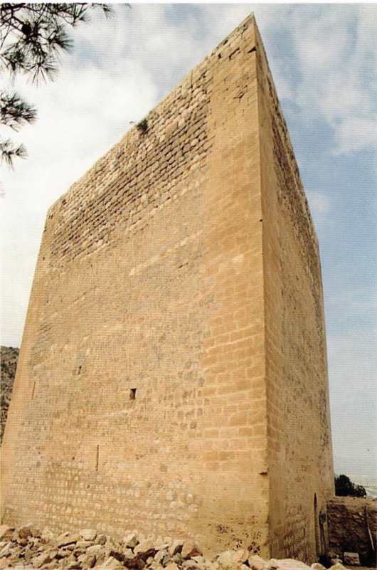
Fig. 229.- Castillo de Novelda (Alicante). La fortaleza de La Mola muestra el absurdo poliorcético de una torre triangular, planta tan original como vulnerable, y quizás obra de un ingenioso Manuel de hacia 1300.
