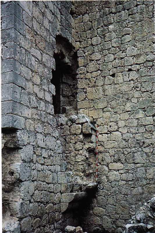
Fig. 189.- Castillo de Pioz (Guadalajara). Puente basculante por contrapeso trasero entre la torre del homenaje y el patín que accede al patio de armas, probablemente de la segunda mitad del siglo XV.
