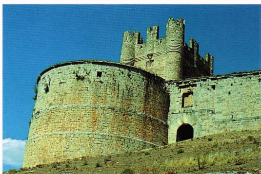
Fig. 245.- Castillo de Berlanga de Duero (Soria). Las escaraguaitas y borjes-contrafuerte de una torre del homenaje correspondiente a la segunda mitad del siglo XV se asoman tras el poderoso cubo suroeste de esta gran fortaleza de los Duques de Frías, cuya construcción debió abandonarse hacia 1528, y en la que pudo intervenir un conocido ingeniero militar italiano, Micer Benedetto de Rávena, que por aquellos años trabajaba para la Corona y también para la Casa de Frías, en su proyecto de corregir los destrozos comuneros de Diciembre de 1520 en su castillo de Villalpando (Zamora), aprovechando para una puesta al día de su acondicionamiento pirobalístico. Estas notables mejoras en las cualificaciones artilleras de ambas fortalezas, soriana y zamorana, pudo guardar relación con la custodia del Delfín y su hermano el Duque de Orleans, que desde 1526 hasta su vuelta a Francia en 1530 fue ejercida por el II y III Duques de Frías, Condestables de Castilla, en Villalpando, Pedraza o Berlanga, todos ellos castillos de los Velasco, y en los que se detectan substanciales reformas fechables por aquellos años.
