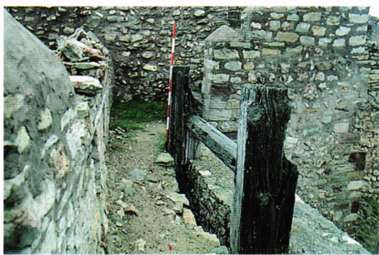
Fig. 204.- Fortificaciones de Molina de Aragón (Guadalajara). Armazón para el torno del rastrillo instalado hacia 1836, con motivo de la primera guerra carlista, en el acceso al camino cubierto que desde el castillo conduce al padastro de la Torre de Aragón.
