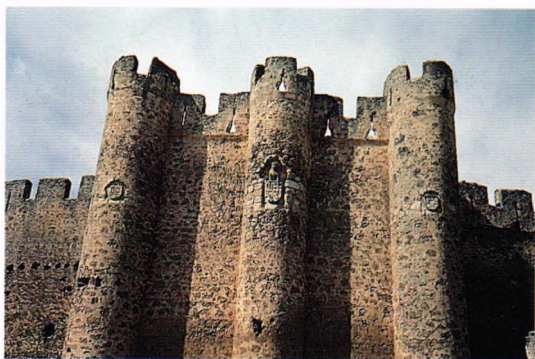
Fig. 56.- Castillo de Valencia de Don Juan (León). Tres de los numerosos borjes, a modo de escaraguaitas-contrafuerte, labrados por los Acuña de Portugal, Condes de Valencia de Don Juan, en la segunda mitad del siglo XV, junto al margen del Esla.
