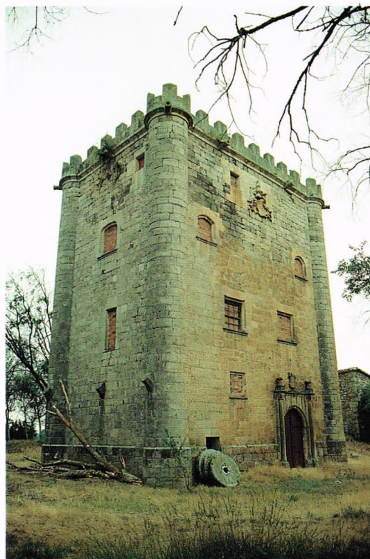
Fig. 257.- Torrona de Olmos Albos (Burgos). Construida para el alavés don Diego Gamarra, estaba terminada en 1554, aunque los salmeres que arrancan de los costados de la torrona sugieren previsión de una triple arcada que probablemente nunca se llegara a instalar, y cuya cubierta, holladera, tendría acceso desde la tercera de las cinco plantas del cuerpo conservado, plantas sustentadas sobre viguería. La torrona está esquinada con cuatro borjes macizos y culminada con crestería de merlones.
