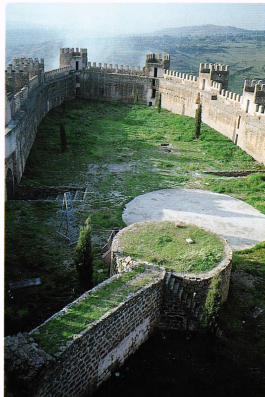
Fig. 159.- Castillo de Baños de la Encina (Jaén). Tramo conservado de la muralla-diafragma que aislaba el sector de la torre del homenaje, «Almena Gorda», del resto de la fortaleza. En 1644 aún conservaba el otro tramo que, partiendo del cubo desmochado, cerraba el reducto; posteriormente debió ser derribado y el muñón de arranque convertido en la escalera que hoy vemos. La muralla diafragma y la torre del homenaje pudieron ser construidas hacia 1400, integrando un reducto o «alcazarejo» dentro de esta fortaleza califal fechada epigráficamente en el año 968.
