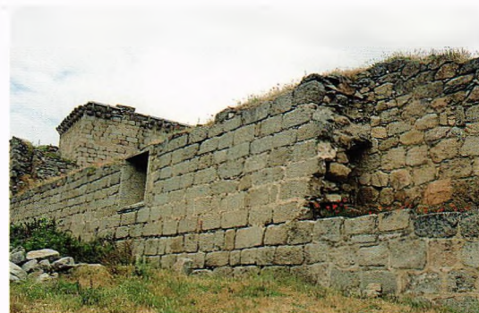
Fig. 160.- Castillo de Bonilla de la Sierra (Ávila). Paramento de sillarejo del siglo XVI forrando otro de mampuestos enripiados probablemente del XIV, en esta fortaleza episcopal abulense.
