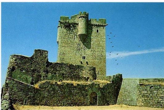
Fig. 197.- Castillo de Sanfelices de los Gallegos (Salamanca). Rampa de compartimentación entre la muralla urbana del siglo XIV y la fortaleza que se labra hacia 1478 don García Álvarez de Toledo, I Duque de Alba, construida con cuidada estereotomía y acusado releje.
