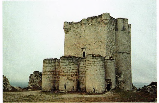
Fig. 246.- Castillo de Iscar (Valladolid). Vista desde el noreste del complejo reducto labrado hacia 1490 por don Pedro López de Zúñiga y Haro (o López de Ayala), II Conde de Miranda del Castañar. Esta original torre del homenaje pentagonal en proa con ocho borjes adosados, se divide en una zona más baja, a modo de antepuerta, que permite el acceso desde su terrado al propio donjón por medio de un pequeño puente levadizo de cigoñales, dominado por matacanes y escaraguaitas. La cámara inferior del donjón está cubierta con bóveda de crucería con apoyo central en un pilar, como en las torres alfonsíes de Aledo y Lorca, o en la coeva de Mombeltrán.
