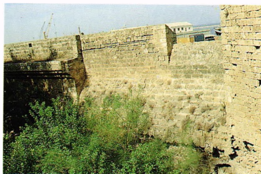
Fig. 198.- Plaza fuerte de Famagusta (República Turca del Norte de Chipre). Rampa de compartimentación que aísla la muralla urbana del extremo noroeste de la ciudadela, obra probable de la etapa del Gobernador veneciano Nicolás Foscarini, en 1492.
