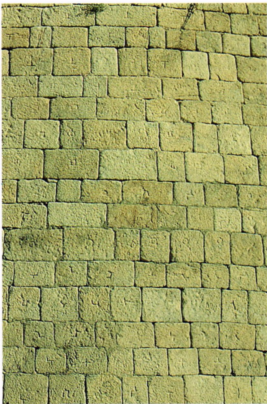
Fig. 125.- Fortificaciones de Ledesma (Salamanca). Amplio muestrario de marcas de cantería en los sillares graníticos de las murallas.
