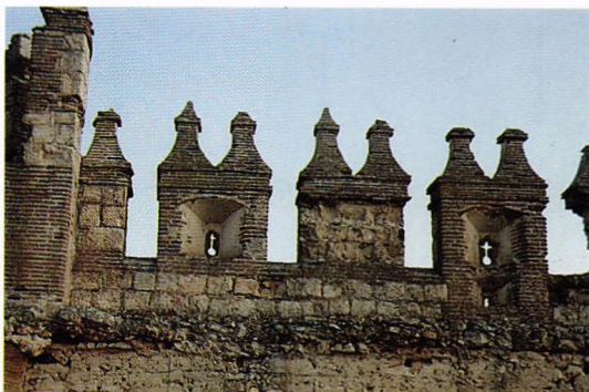
Fig. 152.- Castillo de San Silvestre (Toledo). Debió ser labrada en la segunda mitad del siglo XV por Alvar Gómez de Ciudad Real o, quizás, por los Cárdenas-Enriquez. La imagen muestra el antepecho desde intramuros, con merlatura funcional aunque de historiada albardilla doble, y aspilleras y troneras de «cruz y orbes».
