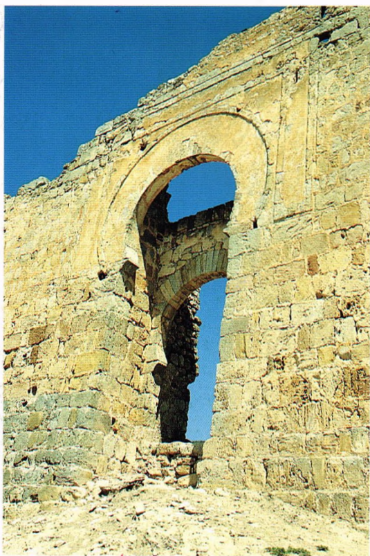
Fig. 57.- Fortaleza de Gormaz (Soria). Buhedera califal de hacia 956-966.
