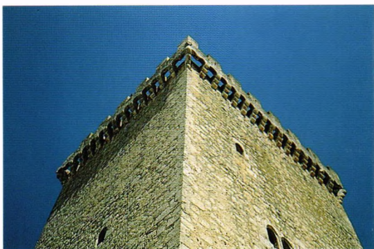
Fig. 148.- Castillo de Peñaranda de Duero (Burgos). Debió ser construida la torre del homenaje en el segundo tercio del siglo XV por don Diego López de Zúñiga y Guzmán, Condestable de Castilla y Conde de Miranda del Castañar, con acceso elevado y ubicación táctica similar a la vallisoletana de Peñafiel.
