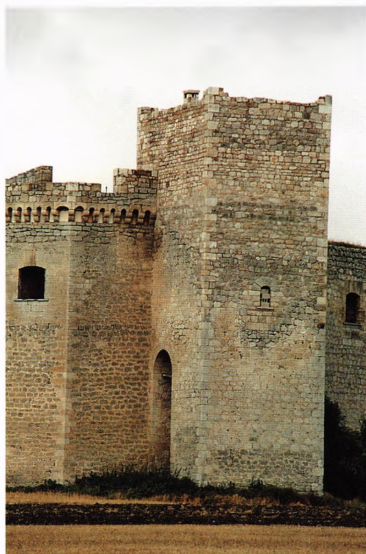
Fig. 235.- Castillo de Sotopalacios (Burgos). Torre albarrana sobre el agua del foso, del Molinar del Ubierna, en el ángulo oriental de la pequeña fortaleza. En el intradós de la albarrana existen tres orificios a modo de buvederas consecutivas, en igual disposición que en la torre del homenaje de Guadamur (Toledo, c. 1468), aunque pudiera corresponderse con artilugios de molienda. A mediados del siglo XVI ya no culminaba en terrado sino en tejavana, que tuvo que ser rehecho en 1598. En la imagen se percibe que la mitad superior del cuerpo de la torre, desde el alféizar de la ventana hacia arriba, está reconstruido recientemente. El castillo sólo tiene otras dos torres sensiblemente mayores, en los ángulos meridional y occidental, giradas 45° según teatrales precedentes gascones y piemonteses, que contrastan en su modernidad con esta arcaizante albarrana, llamada «la torre hueca», que aún así no debe ser anterior al siglo XV, e incluso quizás ocupe parcialmente el chaflán oriental porque no se llegara a construir otra de las giradas, cuya gola sí lo hubiera ocupado todo. Al filo del 1500 debieron hacerse grandes obras defensivas por parte del Adelantado de Castilla don Pedro López Manrique, que en 1507 continúa aún su hijo sin patente de la Corona, siendo apercebido por Juana I.
