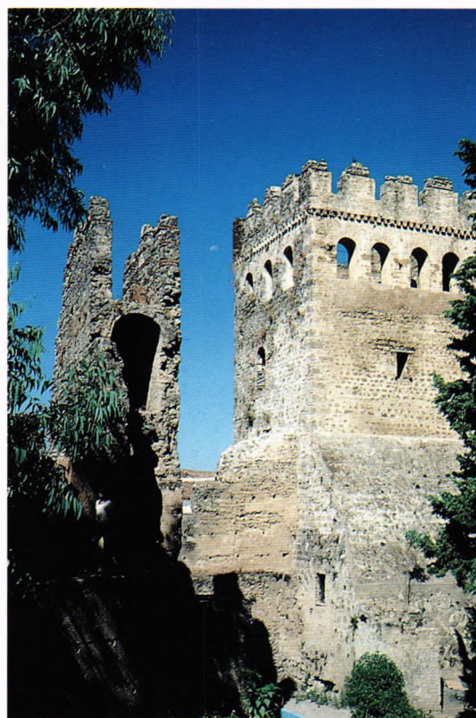
Fig. 36.- Alcazaba de Xauen (Marruecos). Antepecho doble y manga intramural en el antiguo Dar-el-Makbzen, tenidos por saadianos pero que probablemente es obra del segundo de los 'Alawíes, el gran Mūlāy Ismail (1647-1672/1727), quizás en la segunda mitad del siglo XVII.
