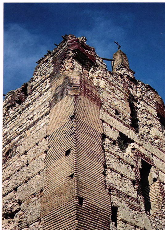
Fig. 12.- Fortaleza de Villafranca del Castillo (Madrid). Achaflanado somero en las esquinas de la zona alta en su torre homenaje, quizás recrecida en la primera mitad del siglo XV sobre otra algo anterior.
