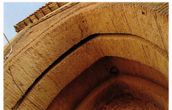
Fig. 202.- Muralla urbana de Valderas (León). Sofito de la arcada en la Puerta de las «Arrejas», mostrando la ranura para el descenso del rastrillo, que aún conservaba en 1928. Debe datar de no mucho después del asedio del Duque de Lancaster a don Alvar Pérez Osorio en 1388, cuando «era logar muy flaco e cercado de tierra», poco más que un aloquín de adobe.
