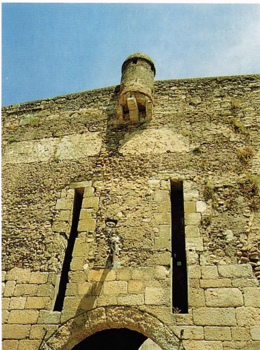
Fig. 123.- Muralla urbana de Ciudad Rodrigo (Salamanca). Garita de centinela, posiblemente de las reformas de Felipe V o Isabel II, sustentada sobre los canecillos de una ladronera quizás coeva a la cerca de Enrique II (1369/1379).
