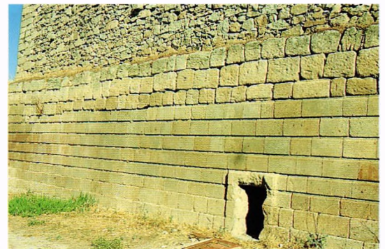
Fig. 40.- Fortificaciones de Ledesma (Salamanca). Zócalo almohadillado, parte del amplio muestrario de aparejos subsistentes en Ledesma, gran parte de él en granito y con marcas de cantería.
