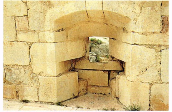
Fig. 71.- Castillo de Mula (Murcia). Cámara de tiro mostrando en las derivas internas las muescas para encastrar algún tipo de cureña correspondiente a piezas de artillería ligera, quizás dotadas ya de eje de muñones, y muy probablemente de retrocarga por alcuza, del tipo verso naval, tan frecuente en las flotas de hacia 1500. El encastre lateral debía corresponderse con un anclaje en el pavimento para inmovilizar el afuste y así, bien afianzado, pudiera absorber el retroceso sin descabalgarse ni atormentar en exceso el montaje de la pieza. La cañonera se abre en el terrado del cuerpo central del castillo (c. 1520-1524), y el grosor del alto parapeto es compartido por la cámara de tiro, que vemos en esta figura, con el abocinamiento exterior, de amplio derrame inferior, que se manifiesta en la figura 6. La fortaleza de los marqueses de los Vélez en Mula, aunque inacabada y algo arcaizante para la tercera década del siglo XVI, es un claro ejemplo de concepción artillera.
