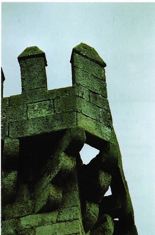
Fig. 147.- Torrona de Olmos de Picaza (Burgos). Tramo de esquina perfectamente conservado del parapeto amatacanado y almenado, con cuidada estereotomía, aunque feble. Debió ser construida en el primer tercio del siglo XV por los Carrillo-Lasso de la Vega, pasando por venta en 1431 a sus parientes los Velasco, Condes de Haro, y más tarde Duques de Frías.
