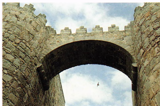
Fig. 23.- Muralla urbana de Ávila. Adarve volado en la Puerta del Alcázar, posiblemente de comienzos del siglo XII.
