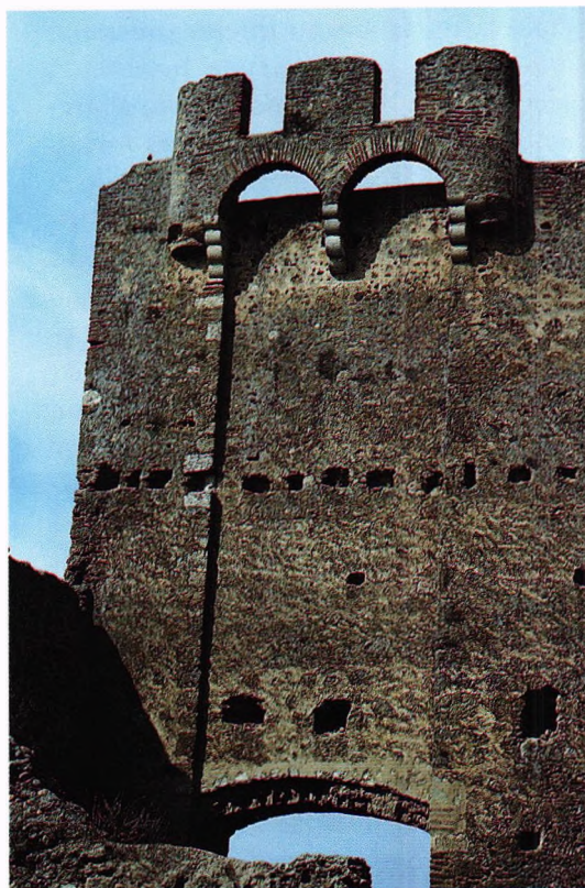
Fig. 135.- Castillo de Valencia de Don Juan (León). Aparatosa e ineficaz ladronera sobre un acceso contiguo a la torre del homenaje, ribereña del Esla. Es obra de los Acuña, Duques de Valencia de Don Juan, hacia 1470.
