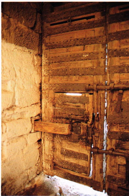
Fig. 30.- Castillo de La Calaborra (Granada). Vista interior de puertas y postigo del acceso principal, con el alamud a medio correr. La carpintería es la original, de hacia 1510.
