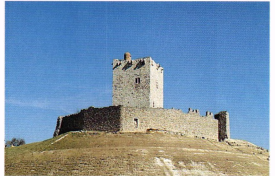
Fig. 80.- Castillo de Tiedra (Valladolid). Curiosa fortaleza, probablemente del siglo XIV en su mayor parte, compuesta esencialmente de una considerable torre del homenaje rodeada de una camisa apenas torreada, configurando un castillo-torreón. El macho, de planta levemente rectangular, corona cada uno de sus lados con tres ladroneras en batería, en coincidencia con el burgalés de Zumel.
