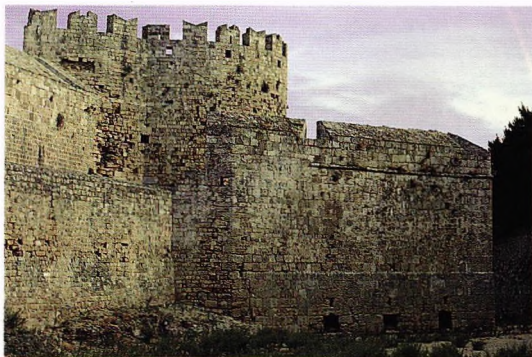
Fig. 78.- Muralla urbana de Rodas (Dodecaneso, Grecia). La torre de España desde el foso, en el sector suroeste de la gran cerca sanjuanista, línea de combate de la Lengua de España en el siglo XV. En su origen una bestorre de flanqueo, fue reforzada considerablemente en 1485, durante el mandato del Gran Maestre Pierre d'Aubusson (1476-1503), envolviéndola en una falsabraga pentagonal a modo de baluarte, con el terrado artillado, así como su base, que barre el foso de flanqueo, en función y temprano ejemplo de caponera.
