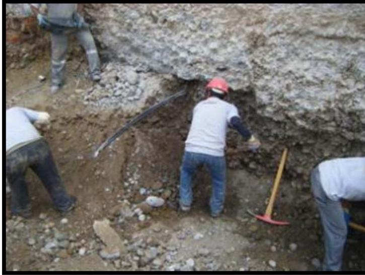
Imagen 25. Perfilado de muro
