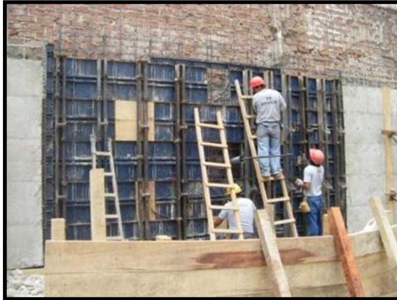
Imagen 31. Vigas de doble canal para alineamiento
