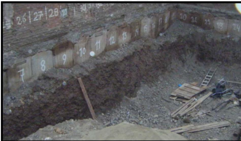
Imagen 07. Excavación de segundo anillo (referencial)
