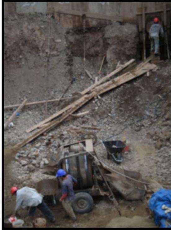
Imagen 13. Vaciado de calzaduras (referencial)
