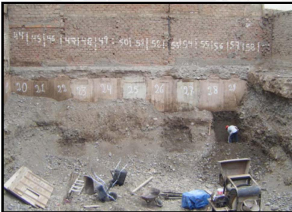
Imagen 08. Excavación de una banqueta (referencial)
