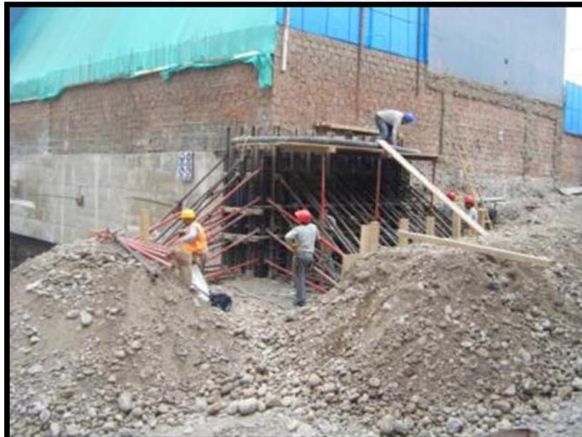
Imagen 32. Contrafuerte armado dejando el muro listo para vaciar
