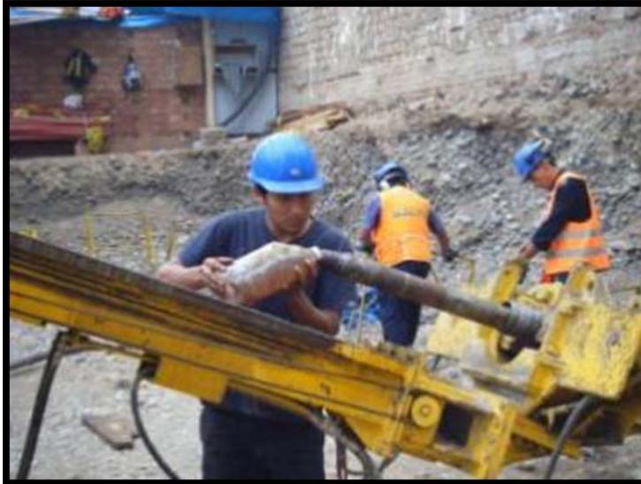
Imagen 17. Colocación de lubricante
