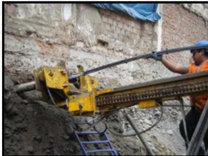
Imagen 22. Inserción de cables para tensado
