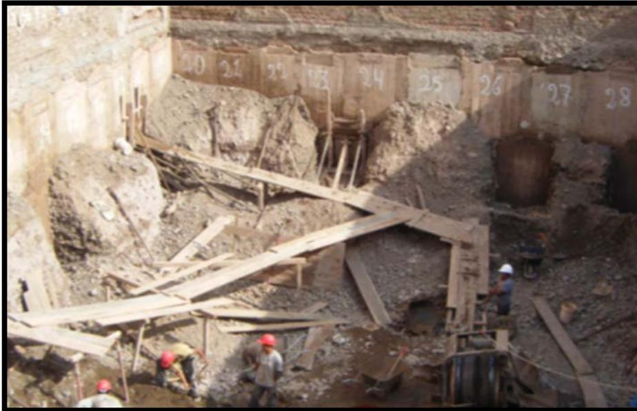
Imagen 12. Encofrado y rampa de calzaduras lista para vaciar (referencial)
