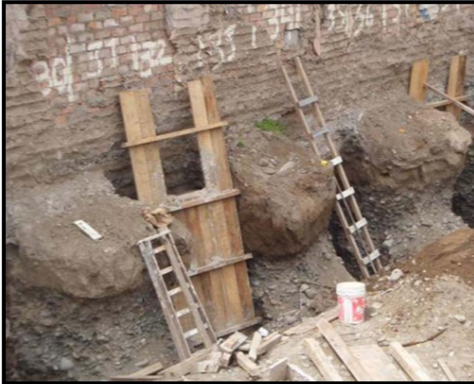
Imagen 10. Encofrado de calzaduras (referencial)
