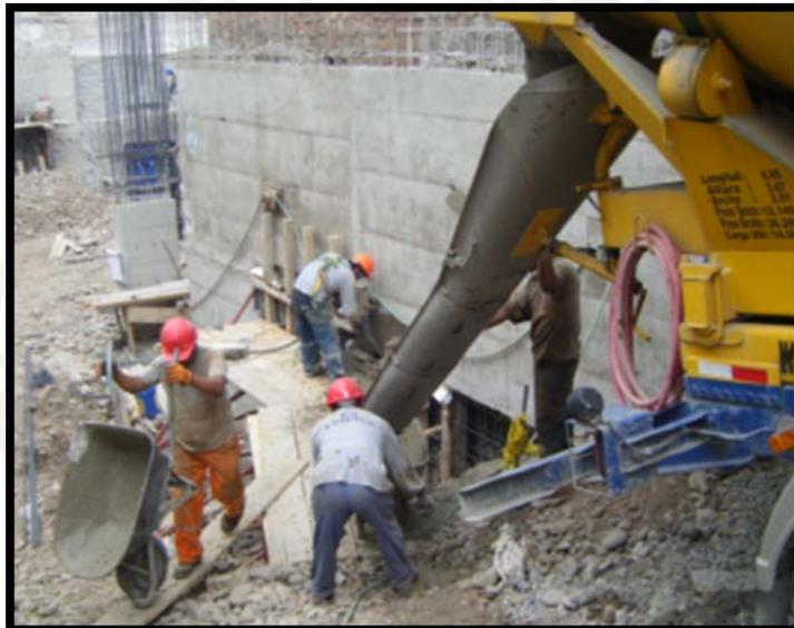
Imagen 33. Vaciado de muro anclado
