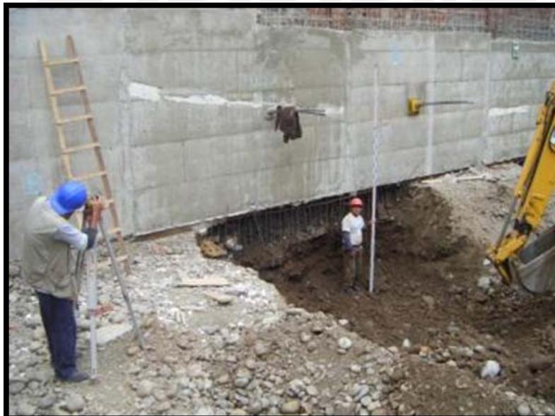
Imagen 24. Excavación de banqueta y perfilado
