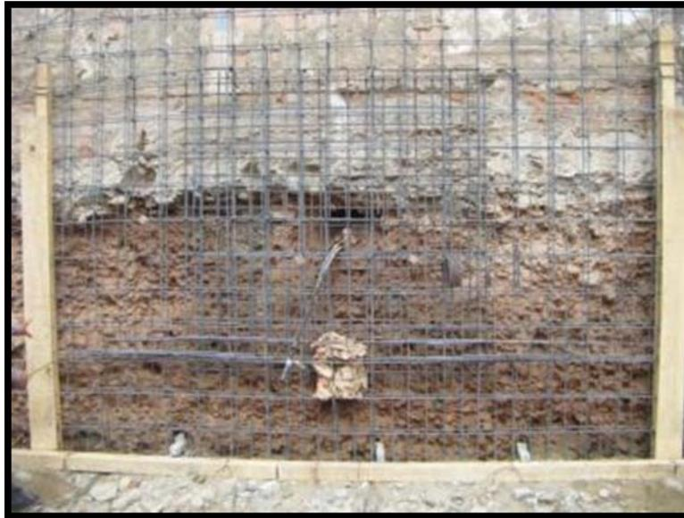
Imagen 29. Muro armado notándose acero de refuerzo
