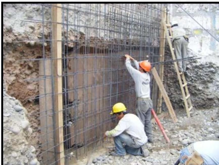
Imagen 28. Colocación de acero
