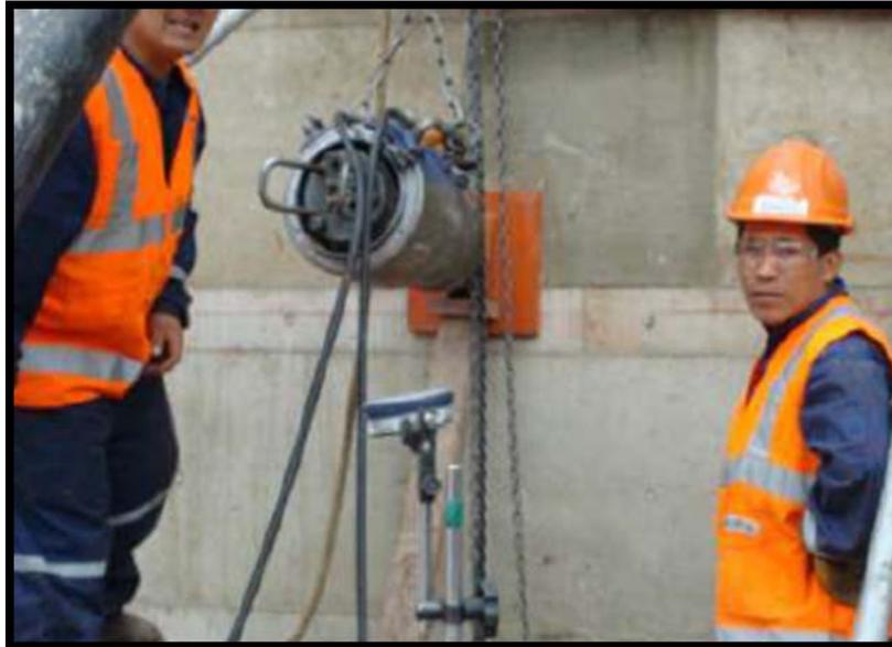
Imagen 34. Tensado de cables
