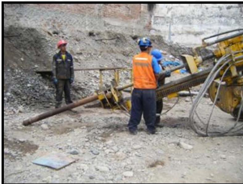
Imagen 16. Armado de taladro y casing
