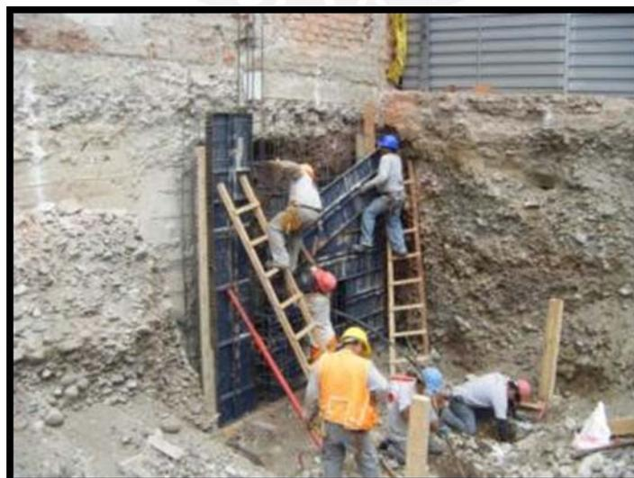
Imagen 30. Encofrado de muro anclado
