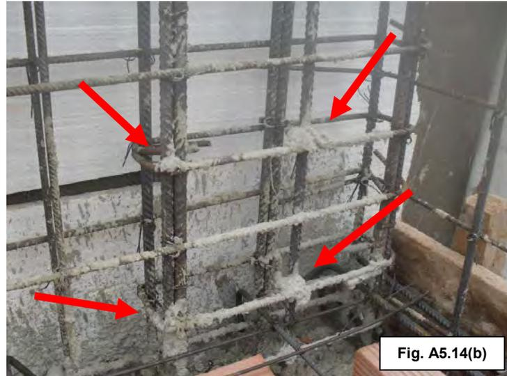
*Figs. A5.14 (a, b, c): Rebabas de concreto adheridas a las barras de acero de las columnas, como producto de vaciados anteriores.*
