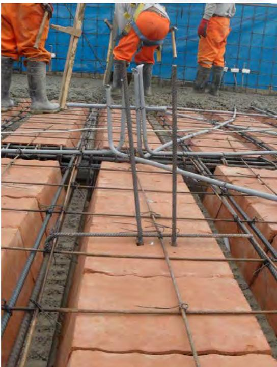
Fig. A6.7: Barras de una columna de arriostre ensartadas en un ladrillo techo.
