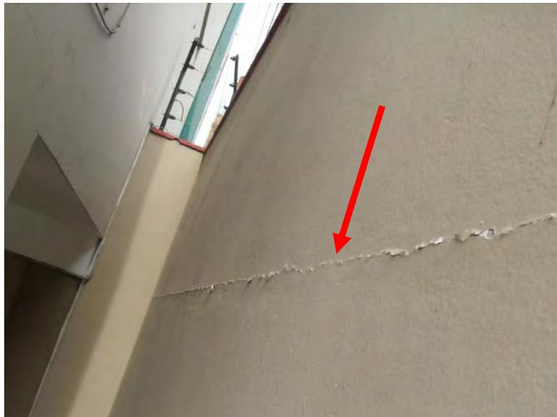
*Fig. A6.13: Fisura producto de la interacción entre dos muros de tabiquería construidos en diferentes momentos.*
