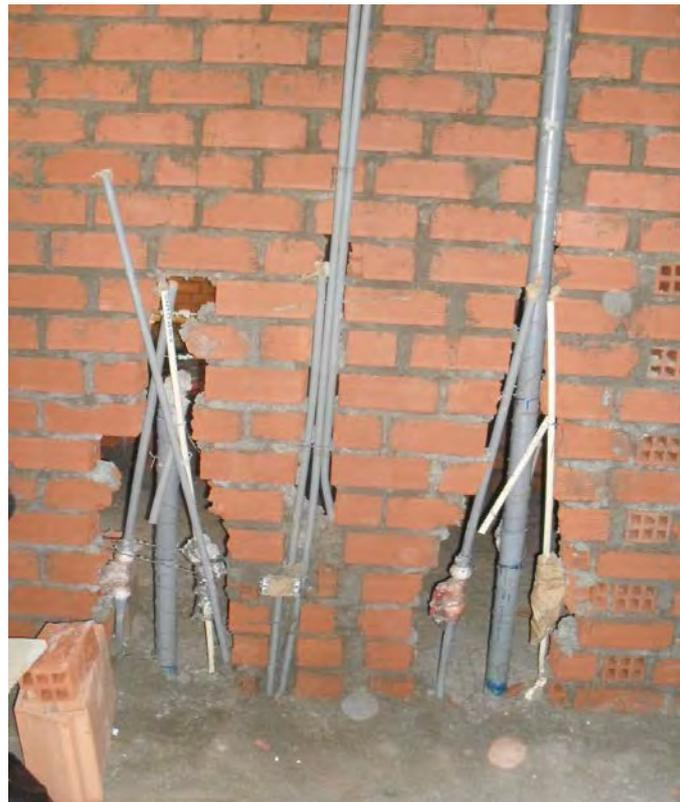
Fig. A6.5: Tabique cortado verticalmente por redes eléctricas y sanitarias.
