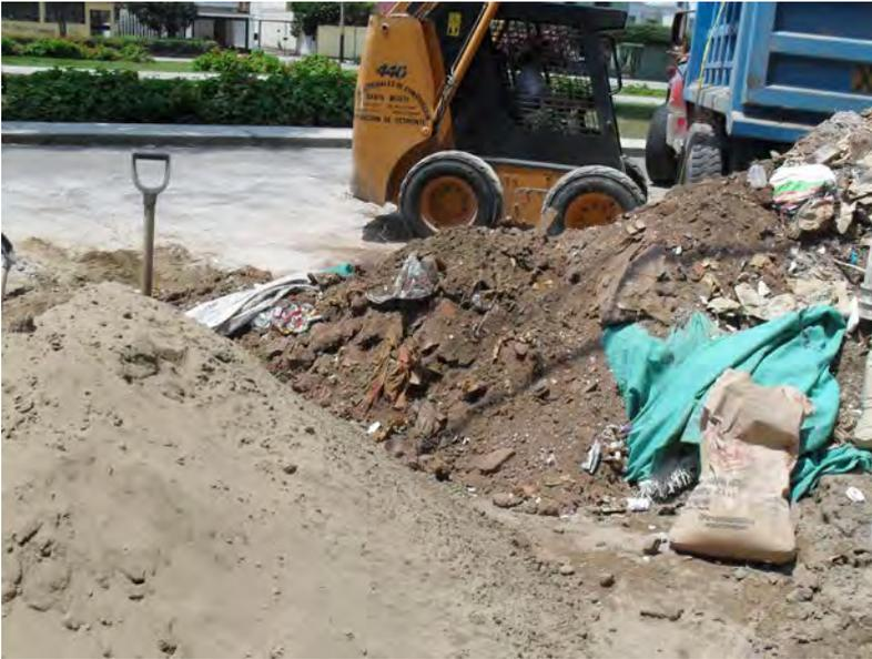
*Fig. A5.5: Acumulación de desmonte junto a un montículo de arena fina, la cual será usada en la construcción.*
