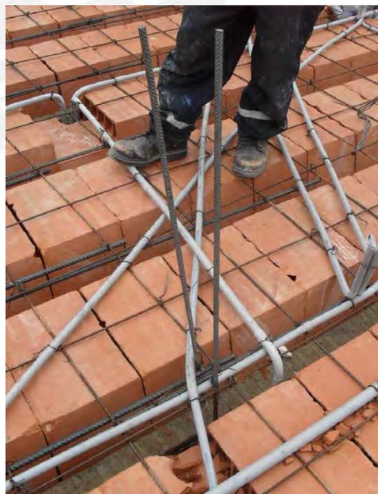
Fig. A6.8: Barras de una columna de arriostre ancladas en una vigueta.
