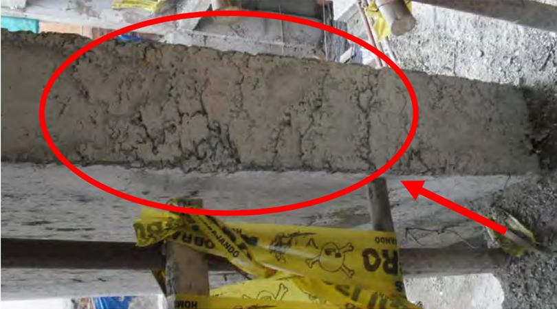
Fig. A5.16: Segregación de agregados en una sección de losa maciza.
