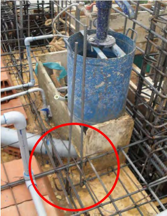
Lo que debe hacerse para conseguir un buen desempeño de la columna de arriostre es retirar el ladrillo y anclar las barras en la armadura de la losa de concreto, con el fin de que se desarrolle el anclaje mecánico. Revisar el RNE E.060 (2006), Art. 12.6.
