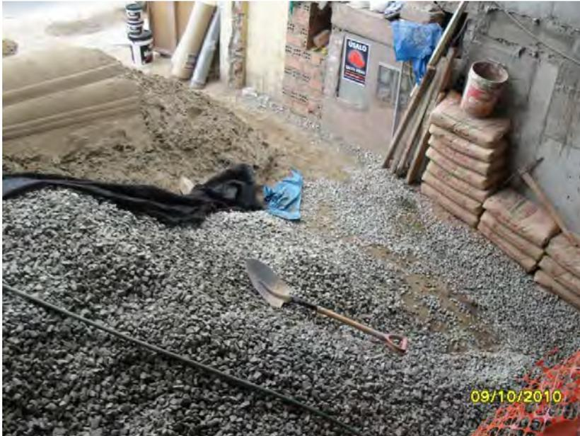
*Fig A5.3: Arena y piedra chancada, inútilmente separados por una bolsa de plástico, al final terminan mezclándose.*
