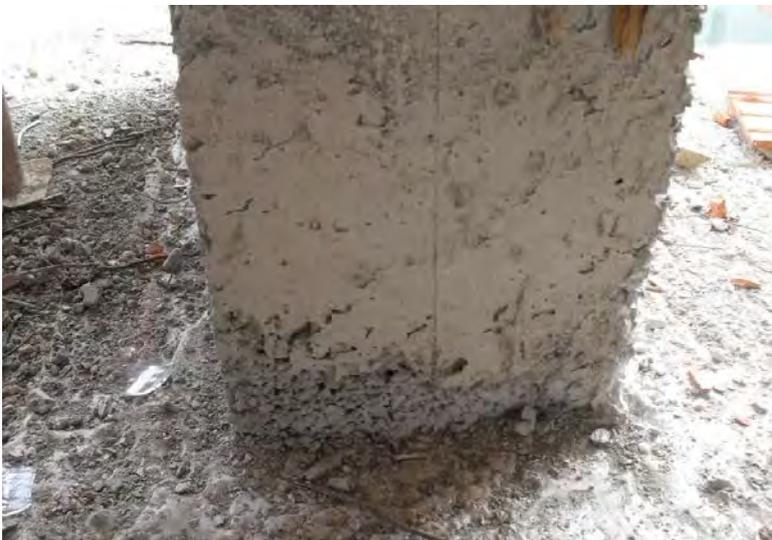
*Fig. A5.13: Parte inferior de una columna. Resultado de la segregación de agregados.*
