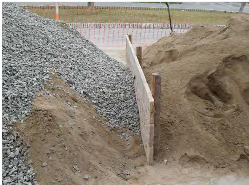
*Fig A5.4: Intento por separar los agregados. La barricada de madera resulta insuficiente pues se aprecia filtración de arena hacia la piedra.*
