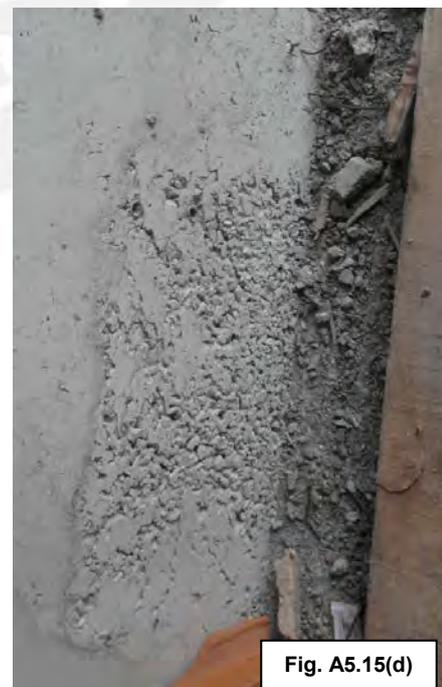
*Figs. A5.15 (a, b, c, d): Segregación de agregados en elementos verticales debido a un mal procedimiento de compactación.*
