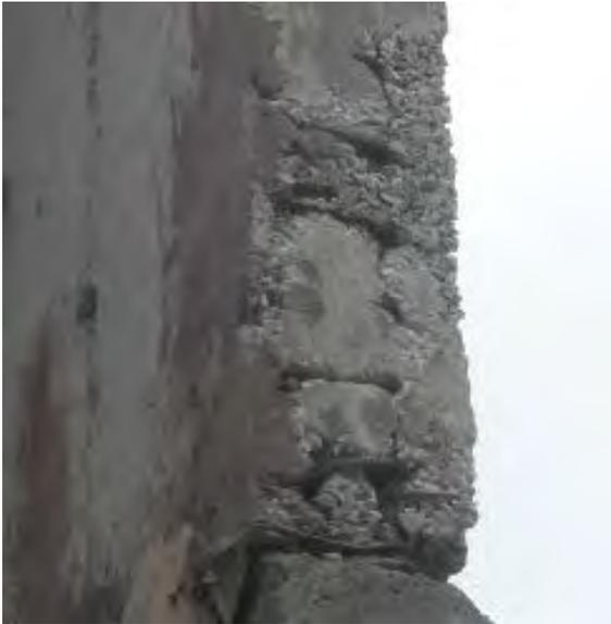
*Fig. A5.18: Cangrejas en el núcleo de una placa (borde exterior), debido a la falta de recubrimiento de ésta.*
