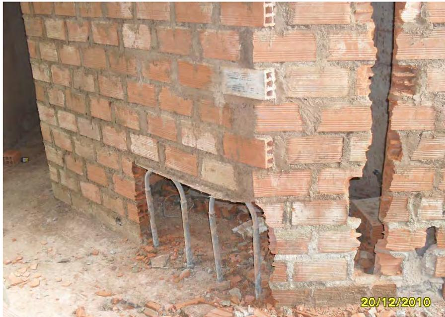
Fig. 6.4: Tabiquería de ladrillo pandereta, sin confinamiento en el encuentro de sus muros, y con parte de su superficie desbastada.
