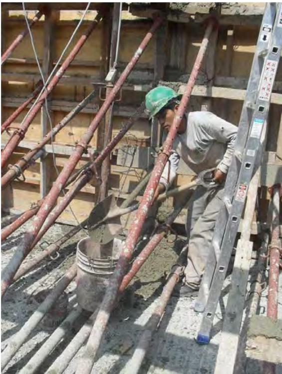
En la figura A5.10 se aprecia a un trabajador recogiendo concreto que se ha derramado en la losa, con el fin de volverlo a vaciar a la placa encofrada. No se recomienda este procedimiento debido a que la losa ha absorbido gran parte de la humedad del concreto, alterando la relación agua/cemento, siendo esta dosificación necesaria para culminar su etapa de fraguado.
