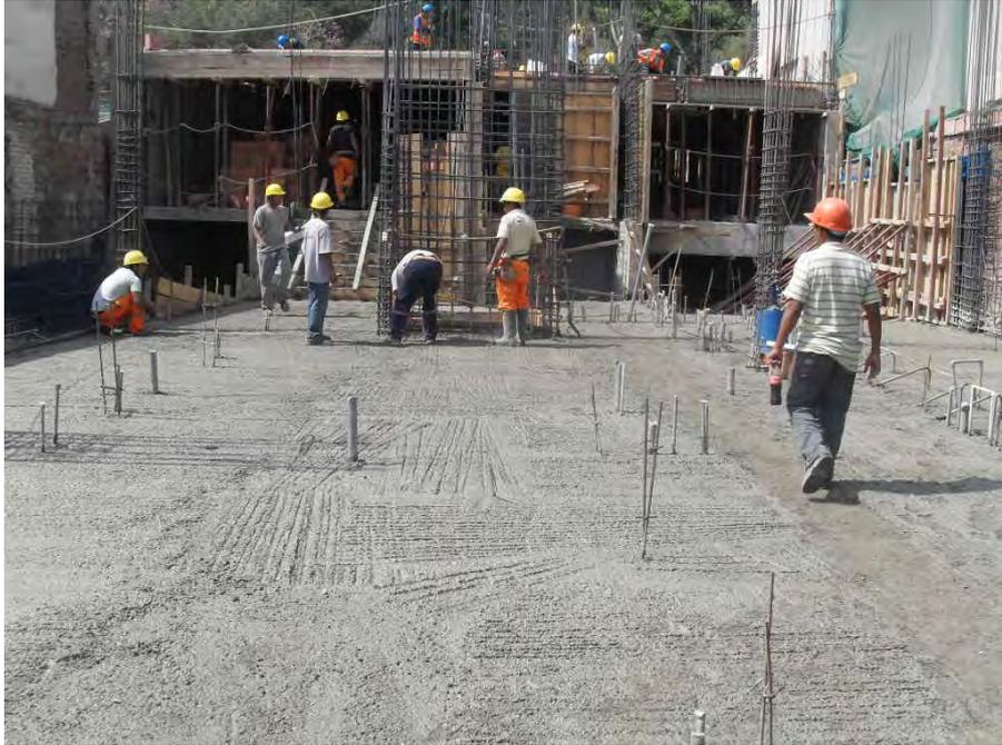
*Fig. A5.20(b): Los trabajadores habilitan el campo para encofrar las mallas de acero, sobre la losa recién vaciada.*
