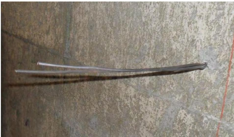
*Fig. A2.6: Típico alambre liso de construcción (doble) inserto en una placa de concreto, para ser usado como mecha de anclaje.*
