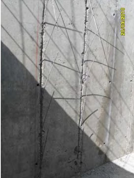
*Fig. A2.7: Varillas de acero descubiertas en una placa de concreto, embebidas en ésta cuando el concreto aún estaba fresco.*
