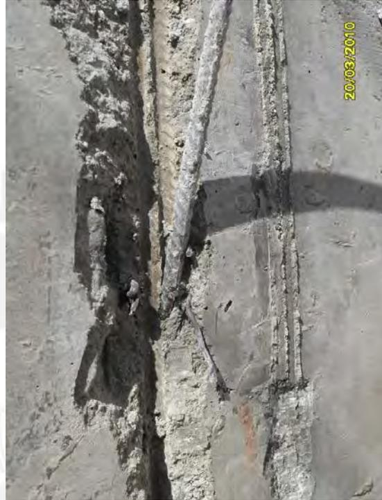
*Fig. A2.8: Acercamiento de una de las varillas de la figura A2.7. Véase el estado de la placa de concreto.*
