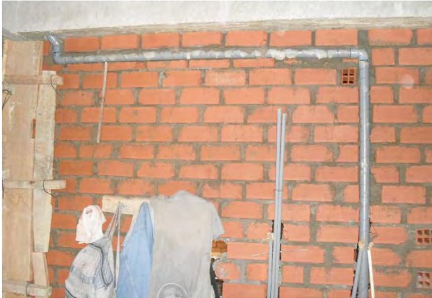
Fig. A6.6: Tabique cortado en dos de sus extremos de confinamiento, superior y lateral.
