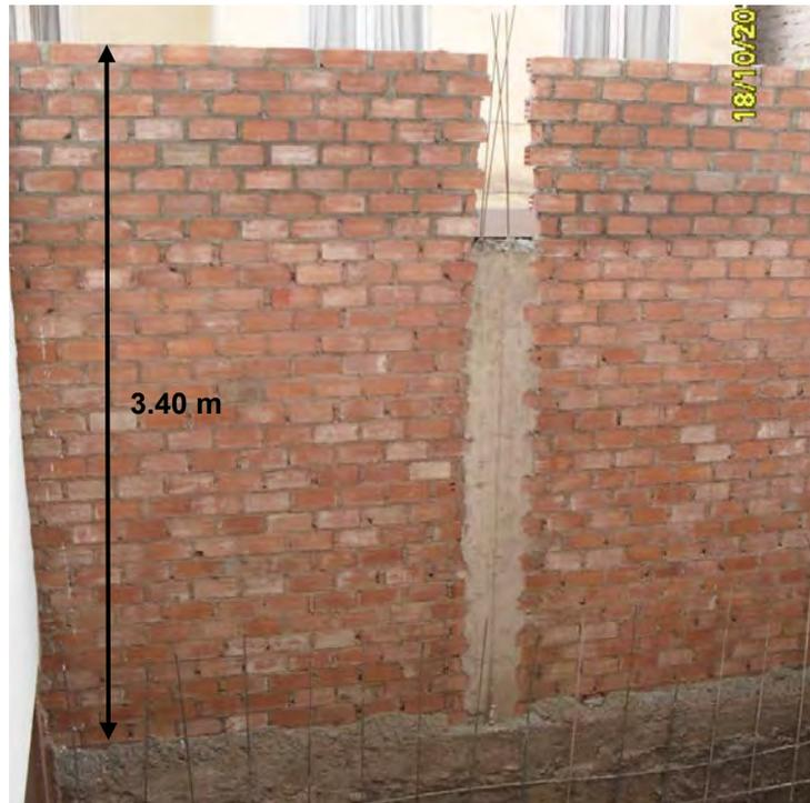
Fig. A6.2: Muro de tabiquería con déficit de arriostre horizontal.
