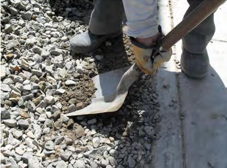
Fig. A5.8: Momentos en que un obrero de construcción recoge agregados para fabricar concreto. Nótese la tierra mezclada con la piedra chancada.
