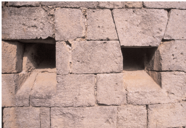
45. Aspilleras en una galería de combate bajo el camino cubierto exterior, en la cala de San Esteban
