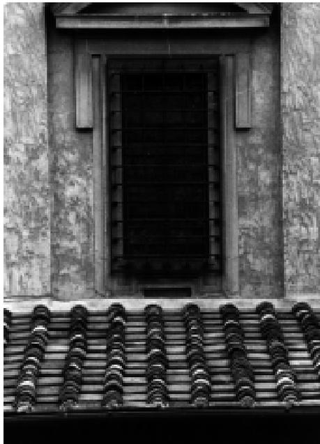
za. Para ello la pieza se abomba y adopta una forma troncocónica, de manera que unas piezas embocan dentro de las otras. La canal cumple el papel de la bandeja romana; se sitúa debajo, con la concavidad hacia arriba, y se enchufa dentro y sobre la inferior para solapar con ella. La cobija se coloca entre las canales, cubriendo la junta y envolviendo la de la hilada inferior para conseguir su solape.
