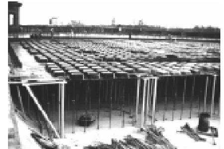
Casetones de aligeramiento de un forjado reticular en el Depósito de las Aguas, Barcelona (Ll. Clotet, I. Paricio).
