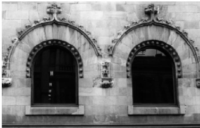
La disposición de dos capirotes unidos evidencia el olvido de su función en la conducción de las aguas. En el punto de unión el agua ha buscado salida destruyendo el moldurado.
