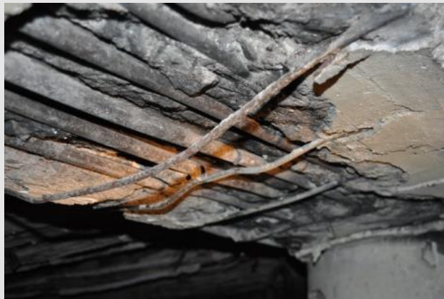
Figura 11. Estado en que quedó el forjado cerámico, la jácena y el pilar más afectados.
