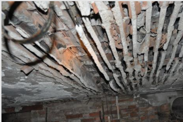
Figura 11. Estado en que quedó el forjado cerámico, la jácena y el pilar más afectados.
