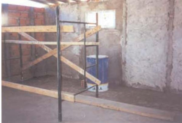
El revoque grueso es el que permite obtener una superficie absolutamente plana y lisa como base para la terminación final, disimulando cualquier imperfección en el paramento de albañilería; huecos, desplomes, juntas salientes, etc.
