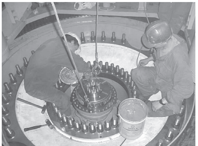
Figura 11.- Maniobra de montaje de los propulsores en el Discoverer Enterprise
