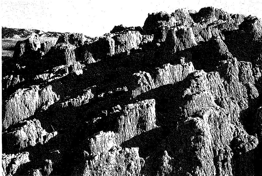
Fig. 3 - Biancana "soufflé": i processi di erosione interna hanno causato la rimozione di parte delle strutture interne della biancana che sta quindi collassando su se stessa.
