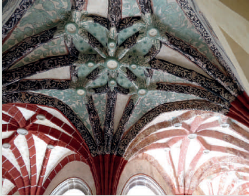
Detalle pintura mural en bóveda de claustro bajo.
