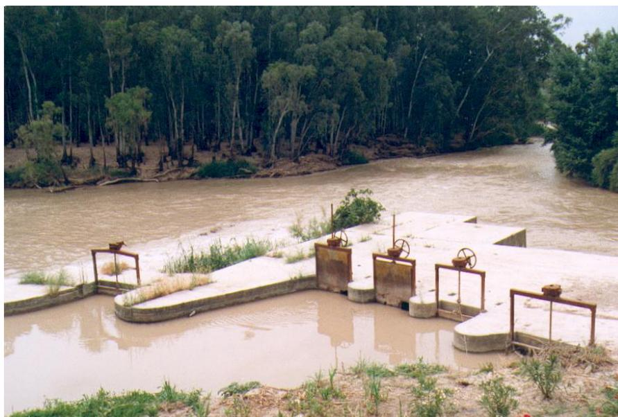
*Fig. 66. Vista actual de la Electroharinera. El volante y aguatocho situado en el extremo izquierdo parece corresponden al canal aliviadero de la azuda.*
