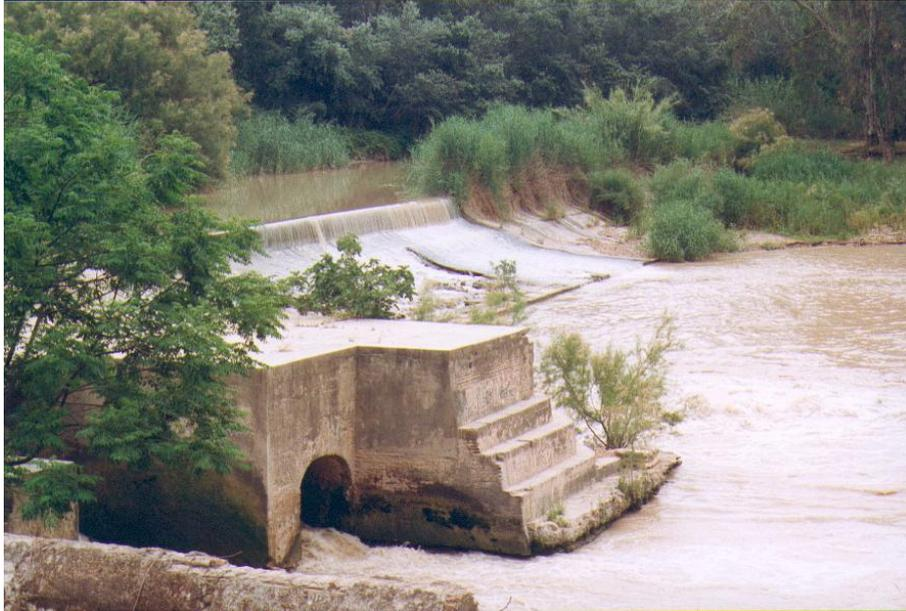
*Fig. 67. Vista de la fachada occidental de la Electroharinera, donde se aprecia el contrafuerte escalonado que debió de formar parte de las antiguas aceñas.*
