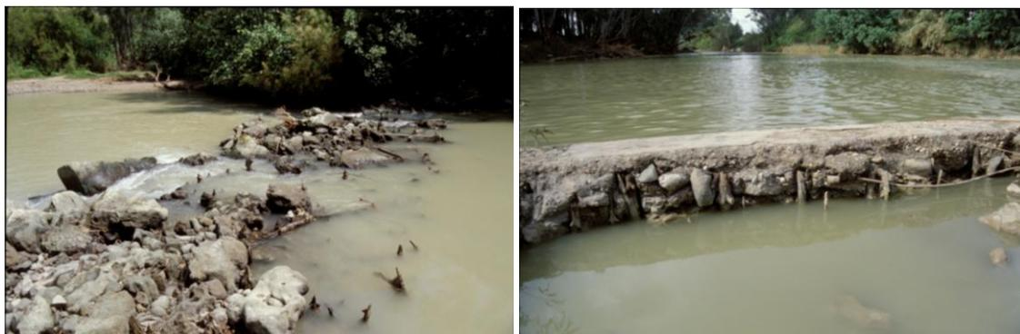
*Fig. 4. En las azudas del Paguillo (izquierda) y de la Electroharinera (derecha) se aprecian con nitidez las estacas hincadas al fondo del río que constituyen la base de sustentación de estas presas de deriva.*
