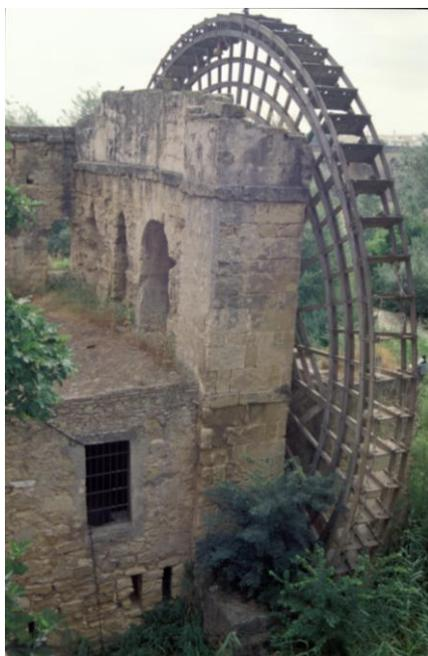
*Fig. 2. La noria de la Albolafia fue reconstruida en 1965 siguiendo fielmente la composición de las ruedas de madera que aún subsistían en los ríos Genil y Guadajoz.*
