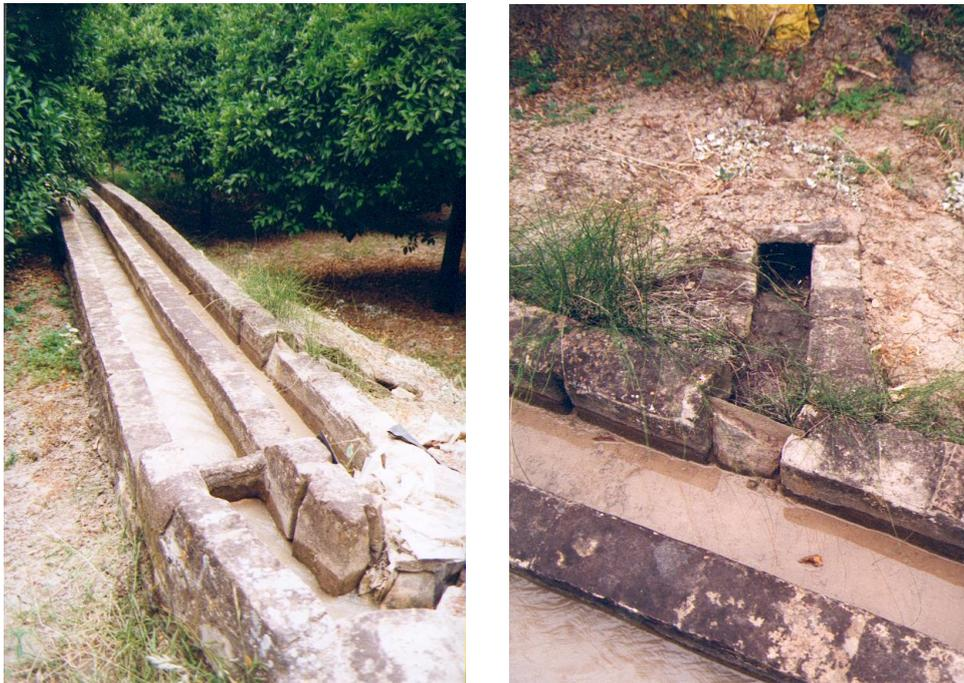
*Fig. 36. Almatriches de la noria segunda del Rincón. Hacia el sur parte este almatriche doble, en cuyo tramo inicial se observa la boquilla con su compuerta de madera que aparece en la imagen derecha.*
