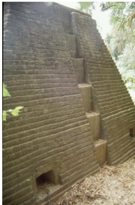
*Fig. 9. Vista del puerto de noria conservado en la azuda primera del Rincón. A la izquierda, soporte y guía del aguatocho y vista general del canal y del estribo norte; a la derecha, el pie de forma piramidal de en que apoyaba uno de los extremos del eje de la noria.*
