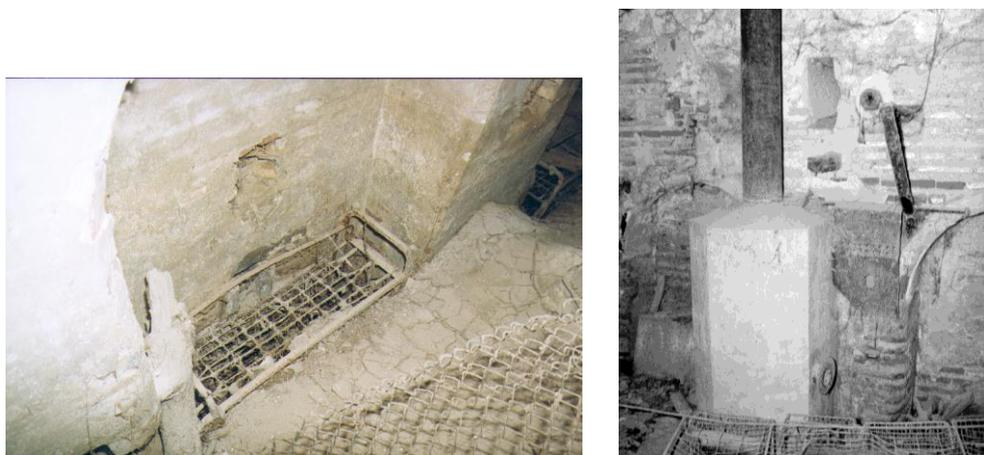
*Fig. 61. A la izquierda, uno de los huecos existentes en el muro oriental del molino para insertar el aguatocho y sus correspondientes guías. A la derecha, los restos del motor bomba utilizado para elevar agua para riegos en los años cincuenta.*
