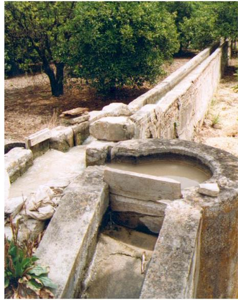
*Fig. 38. Imagen del arranque de los almatrices de la Barqueta, donde se observa el canal que llegaba desde la noria (cubierto de vegetación) y los cuatro ramales que parten desde el inicio del sistema.*
