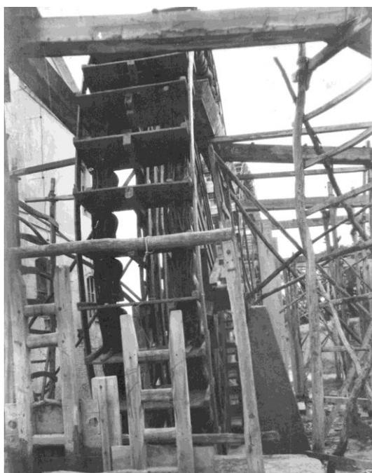
*Fig. 18. En esta imagen de una de las norias de madera instaladas junto a la Electroharinera se aprecian bien los álabes acoplados a hornachiles y motillos, así como las cintas que los rodean por sus lados externos. También los aguatochos, los pies de la noria y el complejo andamiaje que integra las torres para sustentar el ñaquil.*
