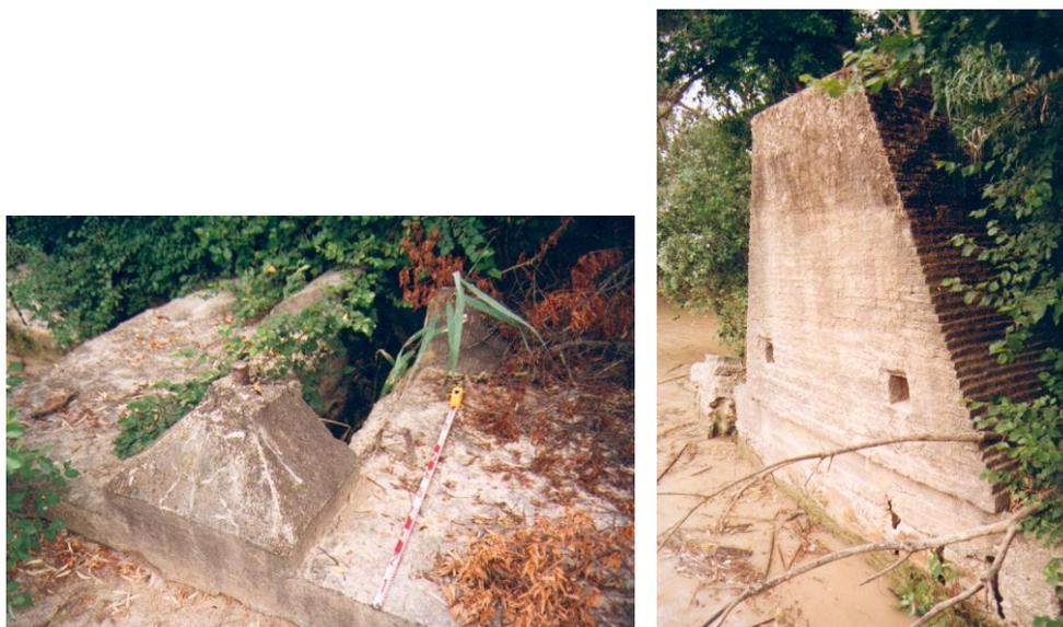
*Fig. 34. Restos del puerto de la noria primera del Rincón. A la derecha, estribo o asiento de la noria y vista del canal donde iba colocada; a la izquierda, aguja donde encajaba el aguatocho.*
