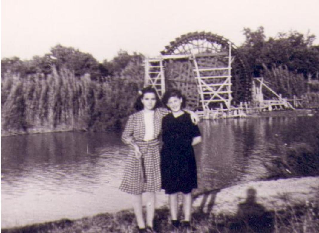
*Fig. 45. Vista de la desaparecida noria de Duque y Flores en la que se observa la rueda de madera, las torres que soportan el ñaquil y el aguatocho y canalizo igualmente de madera.*
