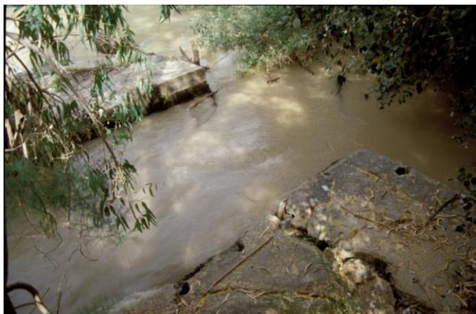
Fig. 6. Vista del canal aliviadero de la azuda primera del Rincón, situado en la margen izquierda del río (la opuesta a donde está el puerto de la noria) para dar paso al agua cuando aquella no funciona.
