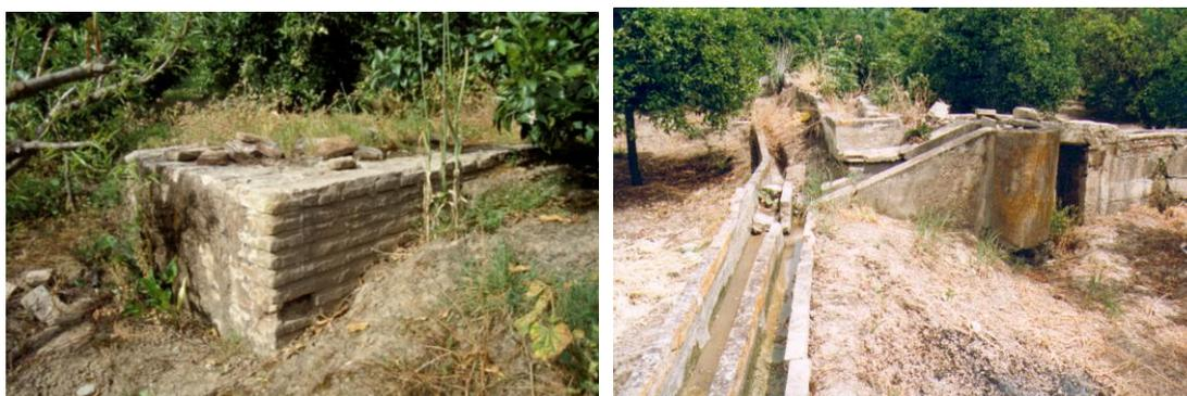
*Fig. 14. A la izquierda, podemos ver la construcción de ladrillo junto a la noria de Arriel, de donde parten los almatriches para el riego de la huerta, mientras que en la imagen de la derecha aparecen los restos del sistema de reparto de aguas situado junto a la noria de la Barqueta.*
