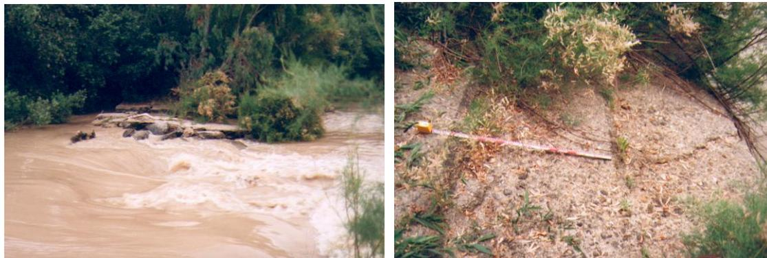
*Fig. 33. Azuda primera del Rincón. En la imagen de la izquierda podemos ver el portillo central que presenta la azuda y, al fondo, los restos del canal aliviadero de la orilla izquierda. En la imagen de la derecha se observa el perfil superior escalonado de la azuda.*
