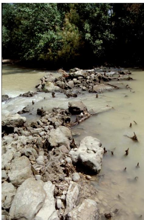
*Fig. 27. Restos de la azuda del Paguillo, donde podemos apreciar las hileras de estacas que componen su esqueleto, las piedras menudas de fondo y las más gruesas que conformaban el rostro o superficie de la azuda, para soportar mejor la acción erosiva del agua.*
