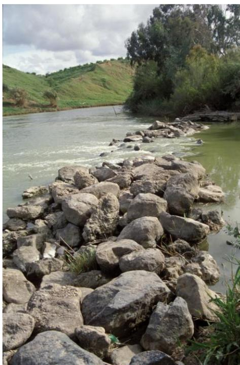
*Fig. 40. Restos de la azuda primera de la Pimentada desde la orilla izquierda del río, en el acceso al pago de la Barqueta. Al fondo aparece la plataforma que sirvió de puerto a su noria.*
