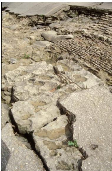
*Fig. 3. En esta vista de la azuda de la Electroharinera podemos apreciar, en el ángulo superior derecho, las pequeñas piedras que constituyen parte de su estructura interna y, en la zona inferior de la fotografía, bajo el desgastado cemento de cubierta, los gruesos sillares que en su día sirvieron de rostro.*
