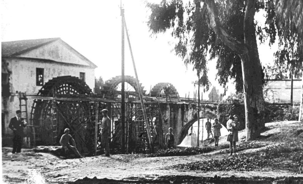
*Fig. 50. En esta conocida imagen de las tres norias, que debe datar de los años 30 o 40, se aprecian algunos cambios: las dos últimas son ya de hierro, como recoge el informe de 1935, y los añaquiles conducen el agua a un almatriche de hormigón.*
