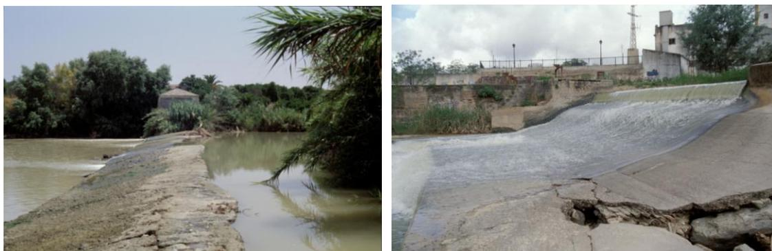
*Fig. 5. Las dos azudas mejor conservadas del término de Palma presentan perfiles diferentes: recto en el caso de la azuda de la noria primera del Carrascal (molino de Los Barrios), ondulado tipo Creager en el caso de la Electroharinera.*
