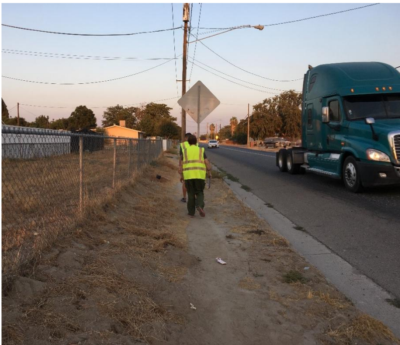
La falta de banquetas en la avenida W.North
