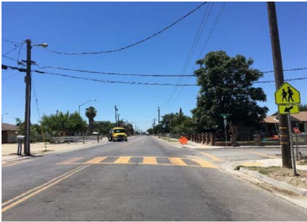
Una cruz escolar de alta visibilidad está decolorando en la avenida Norte y la avenida Clara cerca de la primaria West Fresno.
