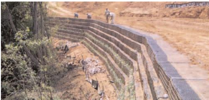
Red metálica soldada
