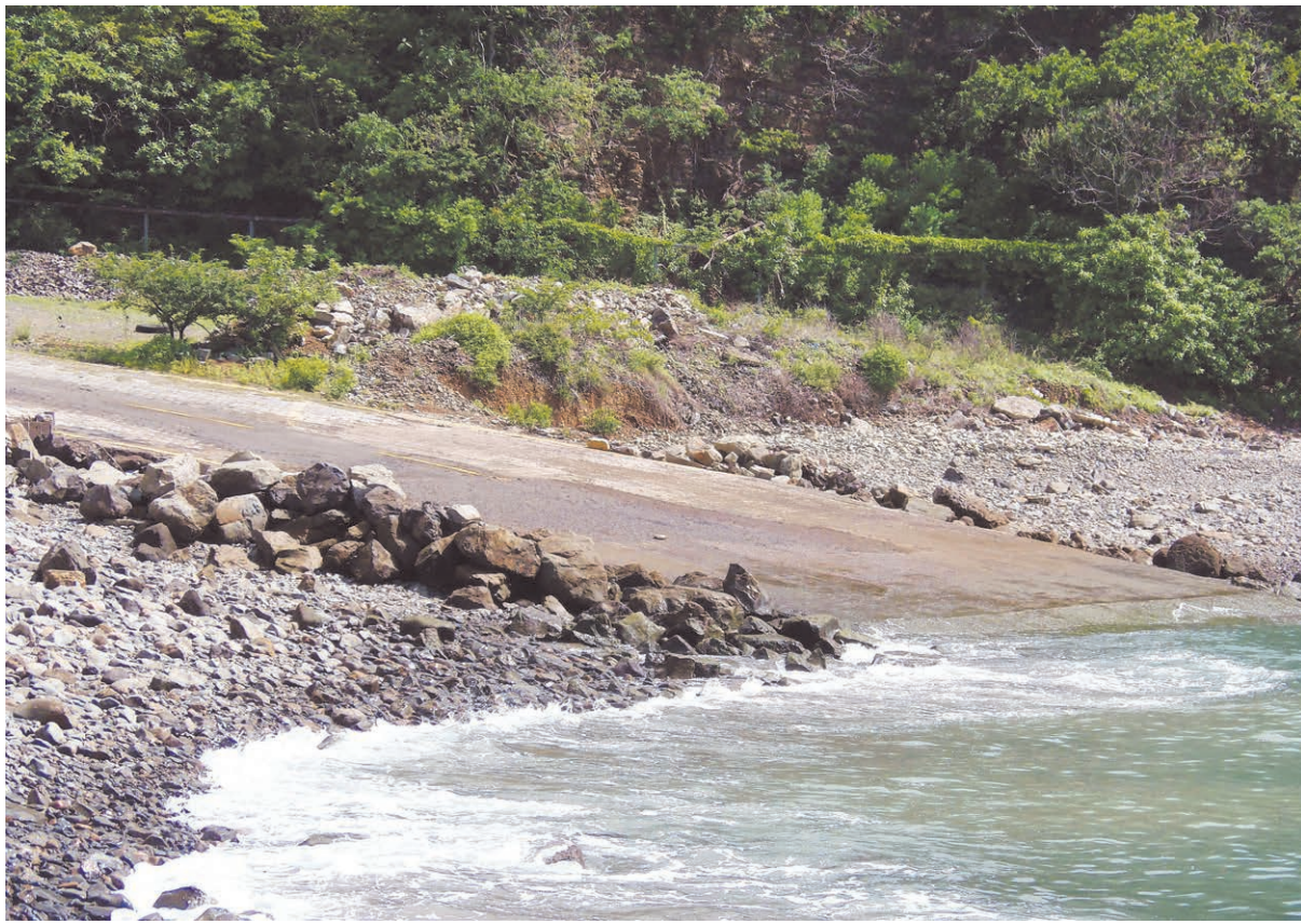
La rampa de la EPN es insegura y no presta condiciones para bajar o sacar botes, denuncian usuarios y pescadores de San Juan del Sur, que ahora ven restringido el derecho al uso de la rampa en la terminal pesquera.
