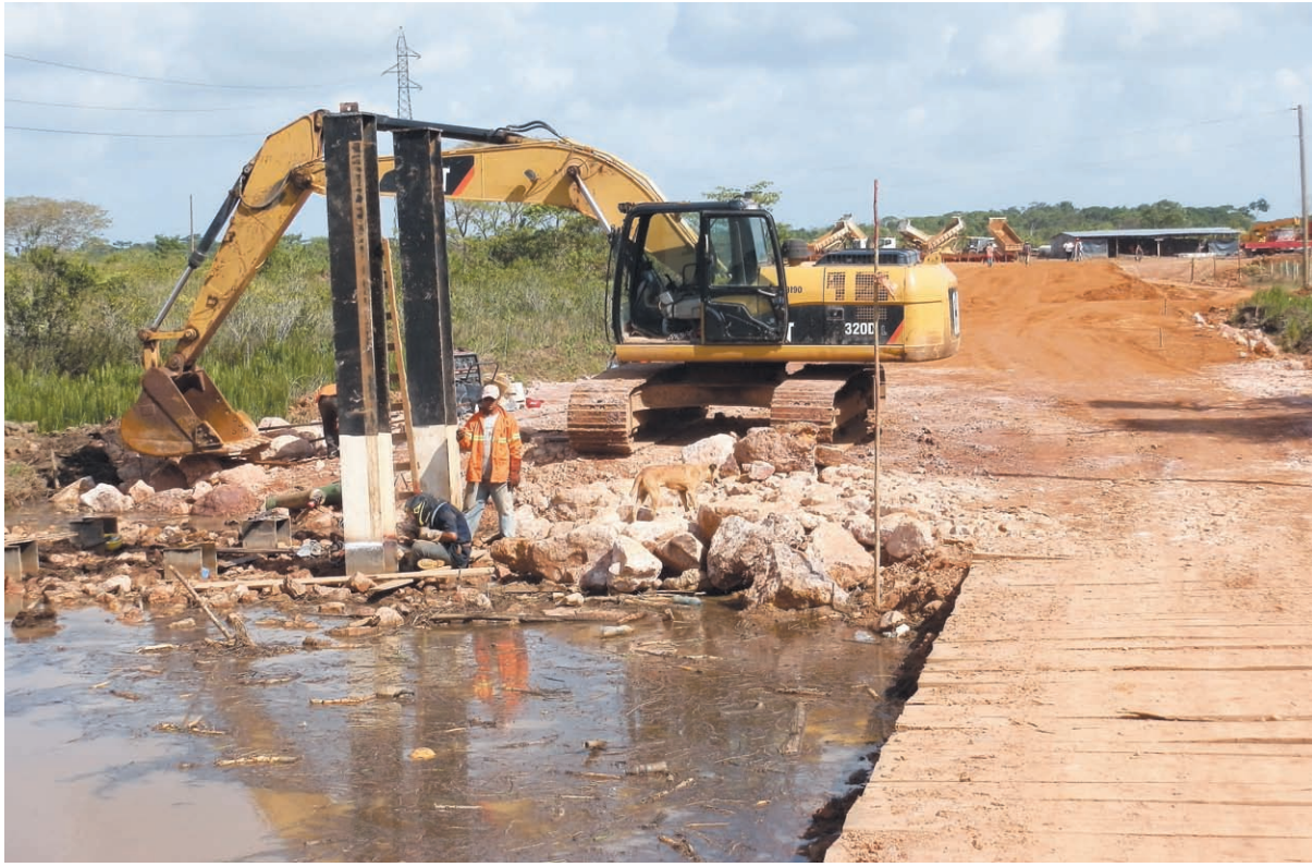
La trocha de todo tiempo conectará por primera vez vía terrestre Bluefields con el resto del país y se espera esté concluida el próximo año.
