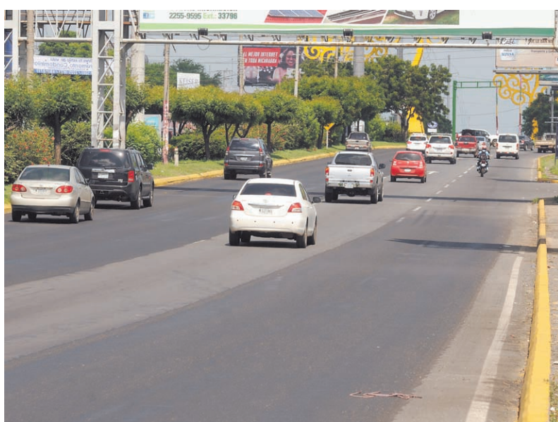
En varias partes de la Carretera a Masaya no existe señalización horizontal, esto confunde a los conductores.
