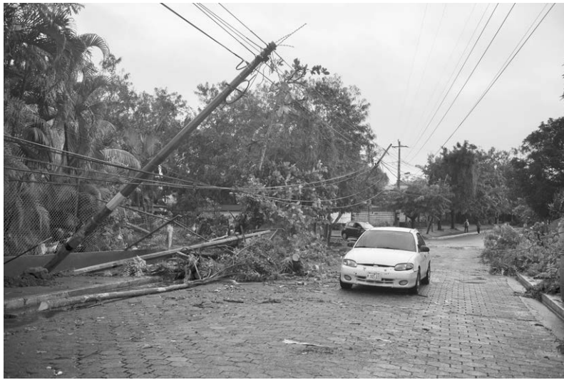
Parte del tendido eléctrico de San Carlos, Río San Juan, fue averiado por los fuertes vientos del huracán Otto.
