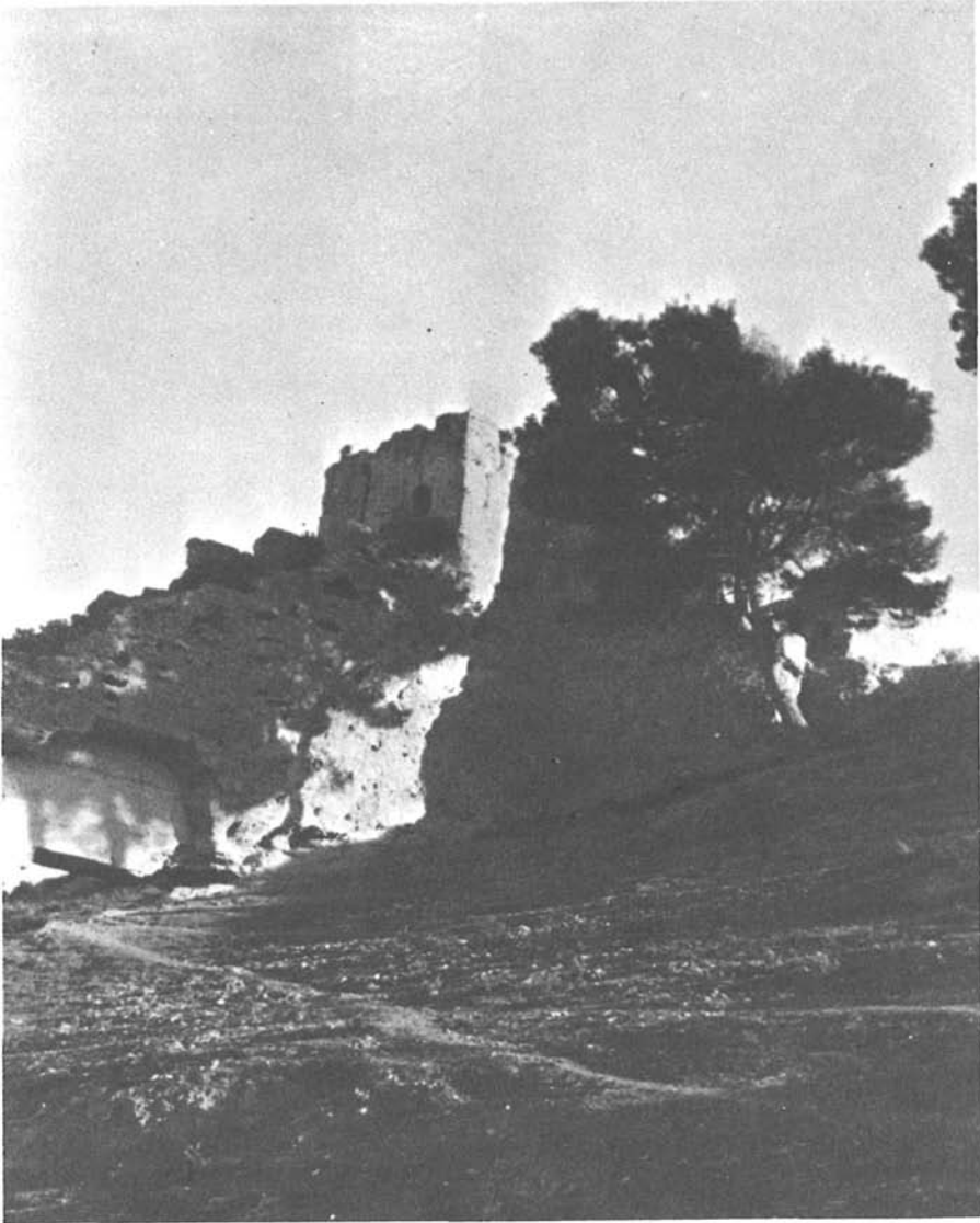
6.—Hunáin: parte de la muralla Este y del bastión Sureste, llamado «Būrj Mūna».
