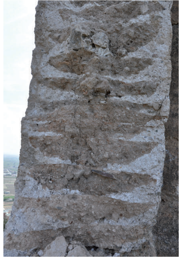
FIGURAS 05 Y 06. Fotografía de tapia calicestrada en el muro norte de la Torre Taifal.
