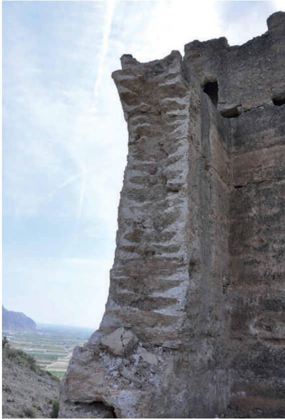
FIGURAS 05 Y 06. Fotografía de tapia calicestrada en el muro norte de la Torre Taifal.
