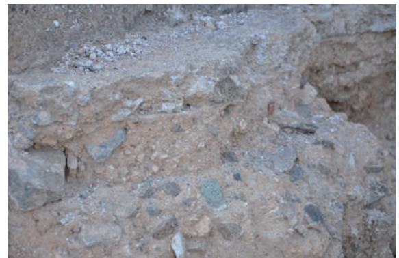
FIGURA 07. Fotografía de tapia real.
