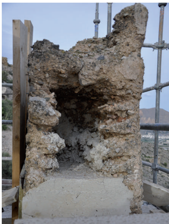
FIGURA 21 Y 22. Uniones entre tramos de ejecución.
