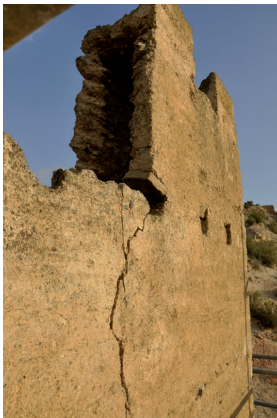
FIGURAS 08 Y 09. Vaciado de muros tapiales.
