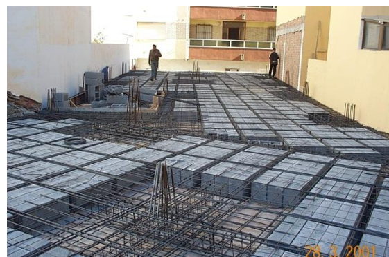
3 Montaje de armaduras
