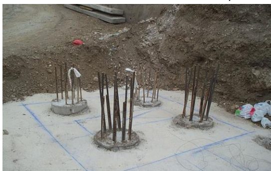
1 Hormigón de limpieza (encepado de 4 pilotes)
