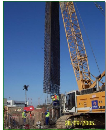
4 Colocación de la armadura
