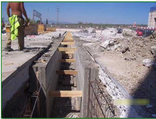
1 Construcción del murete guía
