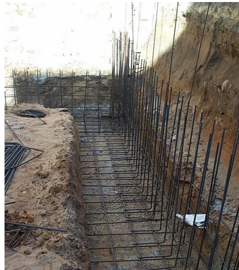
Montaje armaduras de la zapata y de esperas (zapata medianera)
