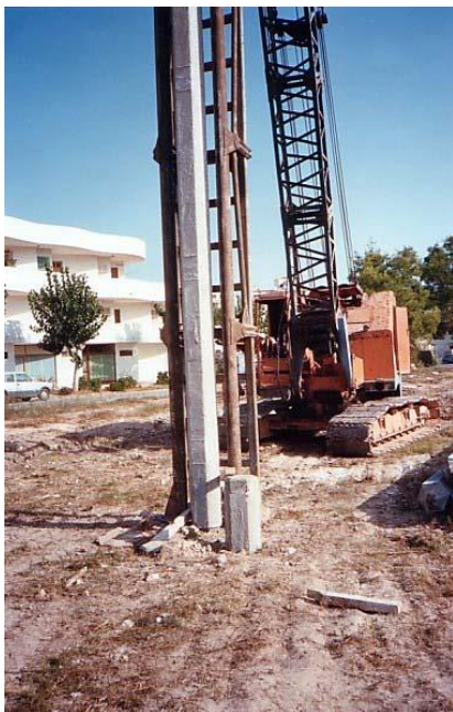
❸ Hinca del pilote
