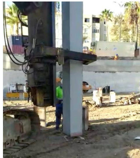
b) Pilotes prefabricados
