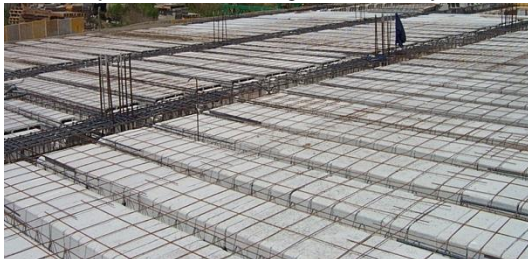
2 Montaje de armaduras de negativo y mallazos
