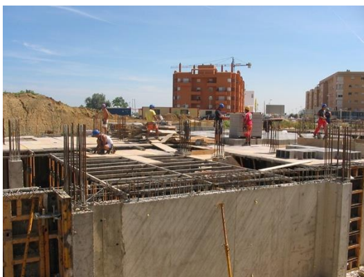
4 Muro finalizado. Enlace con el forjado
