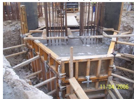
4 Hormigonado (3 pilotes)
