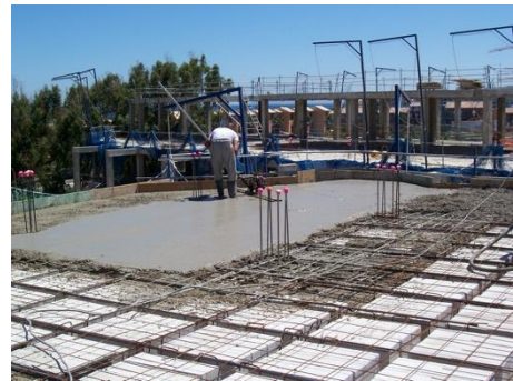
1 Construcción de forjado (intermedio). Una vez construido quedan las esperas para seguir con la construcción del siguiente tramo del pilar.
