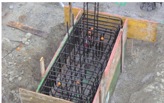
3 Montaje encofrado, si es necesario (2 pilotes)
