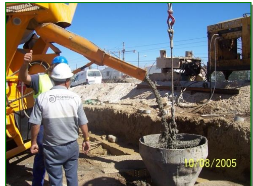
5 Hormigonado (con tubo premie)
