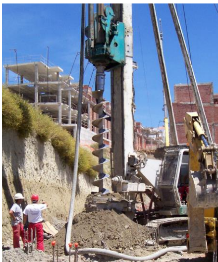
a) Pilotes "in situ"
