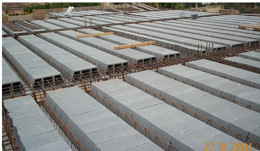
1 Montaje de armados de vigas, brochales y zunchos
