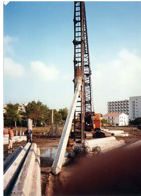
❷ Manipulación del pilote para su colocación
