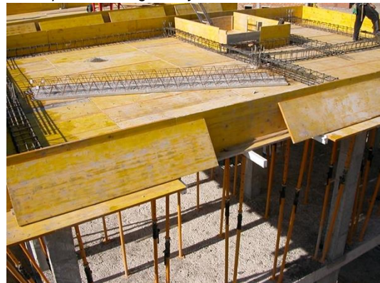
1 Construcción del encofrado (CON tablero continuo)
