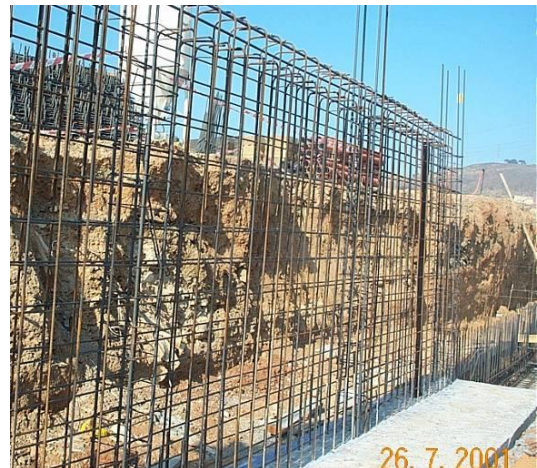
1 Montaje de armaduras de alzado de muro
