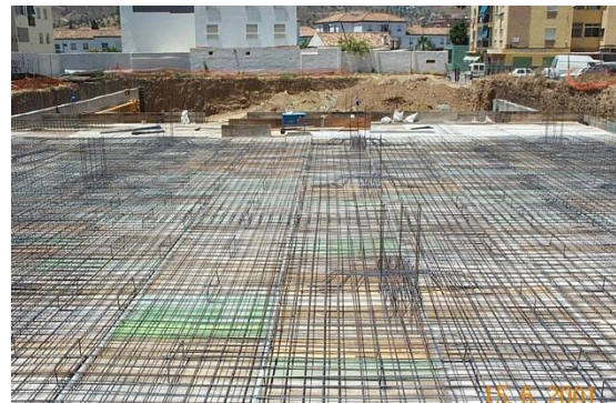
2 Montaje de armaduras
