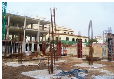
4 Montaje armadura del pilar (tramo planta baja) sobre la armadura de espera en zapata
