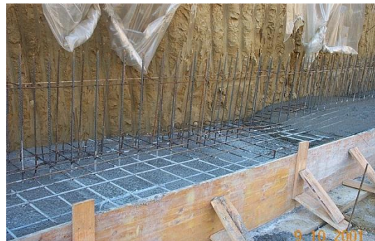
Hormigonado (zapata medianera)
