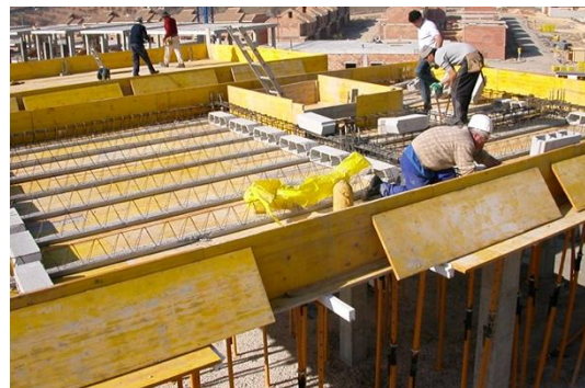
2 Replanteo de viguetas y colocación de bovedillas
