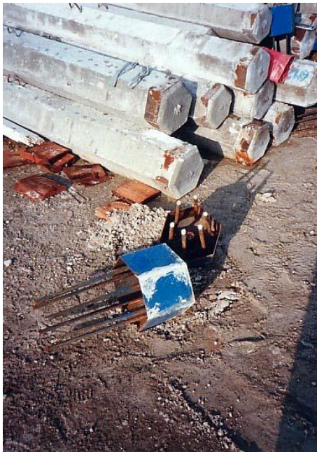
❶ Acopio de pilotes
