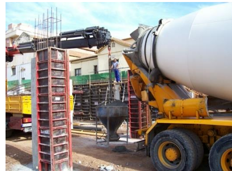
3 Encofrado y hormigonado
