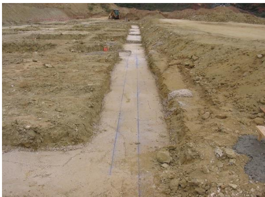
Hormigón de limpieza y replanteo (zapata centrada)
