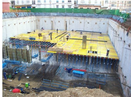
1 Construcción del encofrado con tablero continuo
