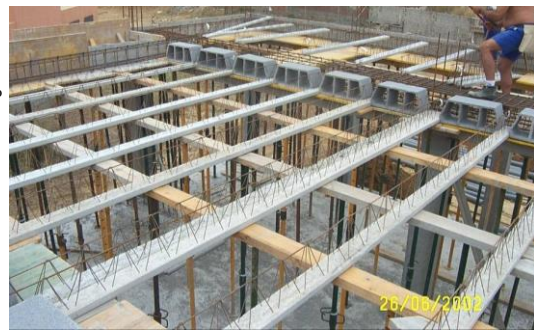
1 Construcción del encofrado (sin tablero continuo) y replanteo de viguetas y colocación de bovedillas
