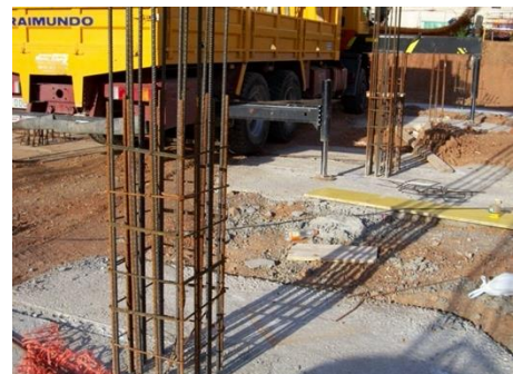
4 Montaje armadura del pilar (tramo planta baja) sobre la armadura de espera en zapata
