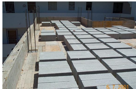
2 Replanteo de casetones
