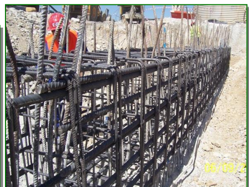
7 Armado viga coronación
