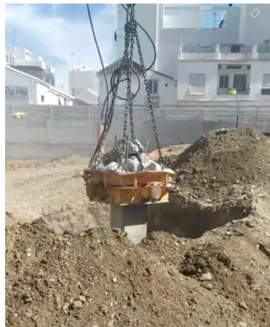
❹ Descabezado del pilote
