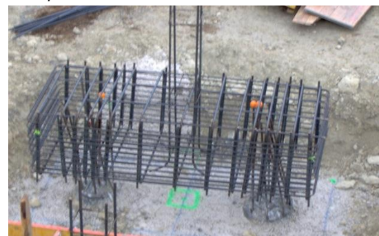
2 Montaje de la armadura pasiva del encepado y esperas del pilar (2 pilotes)
