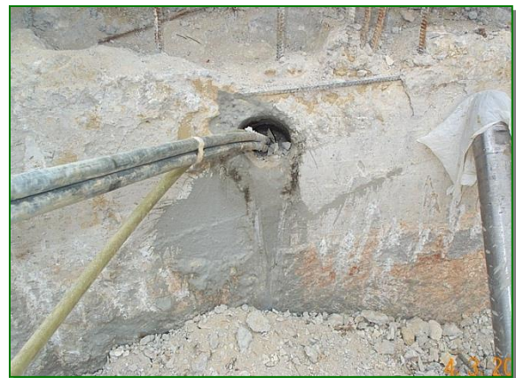
2 Colocación de cordones e inyección
