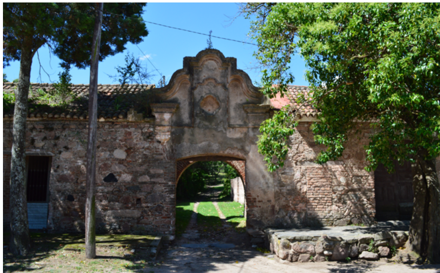
Fig. 7. Portal del ingreso al conjunto habitacional de los trabajadores esclavizados de Santa Catalina.
