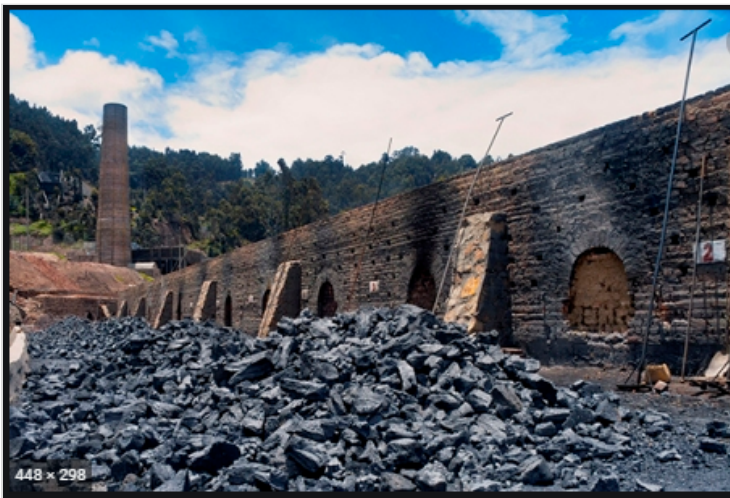
Imagen 2. Etapa final de Hornos Colmena Fuente: (INCARSA, 2020)
