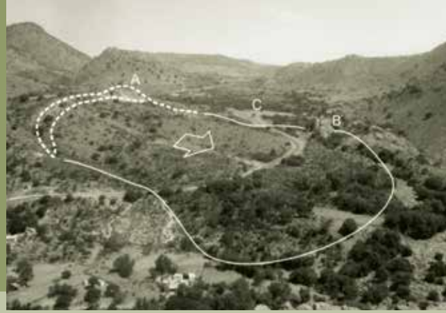
Figura 5. Deslizamiento de una ladera sobre la carretera Ahualulco-Moctezuma. En el punto A se observa el escarpe que deja la masa de terreno deslizada. El cauce del arroyo fue obstruido durante algún tiempo en el punto B, que provocó la formación de un pequeño lago o represa natural en el punto C.
