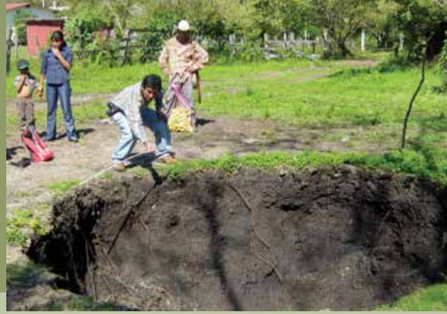
Figura 3. Hundimiento por colapso de una caverna a un costado de la escuela primaria de Tampaxcal, municipio de Tamasopo, S.L.P.
