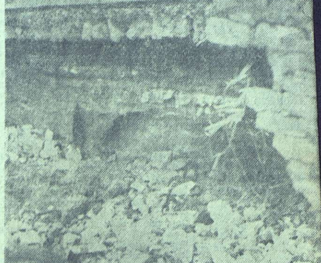
Vista del puente "Carrasco", de la carretera que conduce de Camagüey a Vertientes, que se desprendió por los efectos de la crecida del río del mismo nombre. El puente se halla cerca de la entrada de la capital agraria montina.
